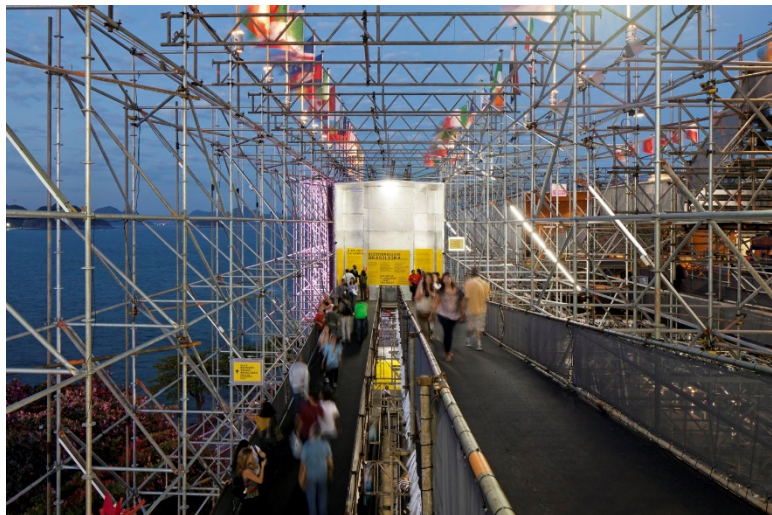
Imagen 29: Pabellón de Humanidades. Río de Janeiro. 2012. https://arquine.com/obra/pabellon-humanidades/
