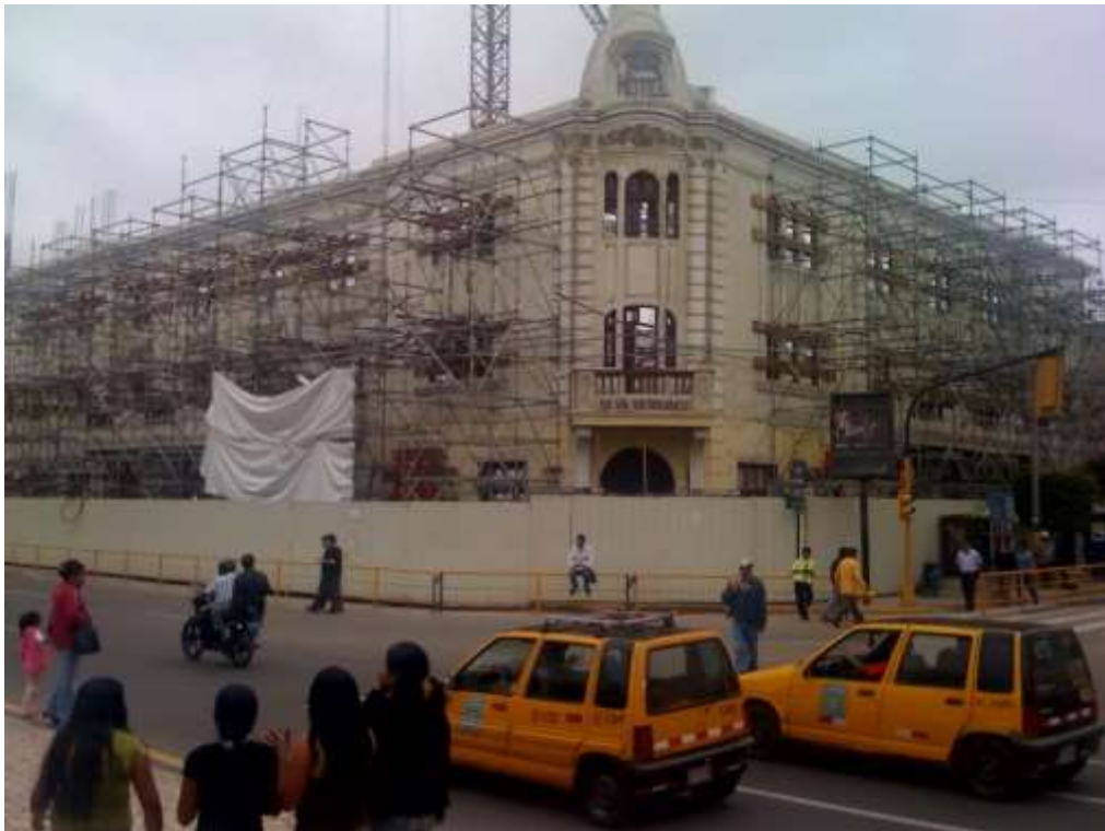
Ilustración 2: Fotografía de Hotel Royal durante las obras de demolición en el 2009
