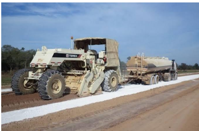
Ilustración 10: Estabilización con cal en campo
