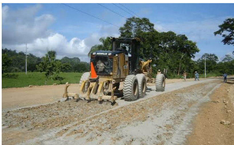
Ilustración 11: Estabilización con cemento en campo
