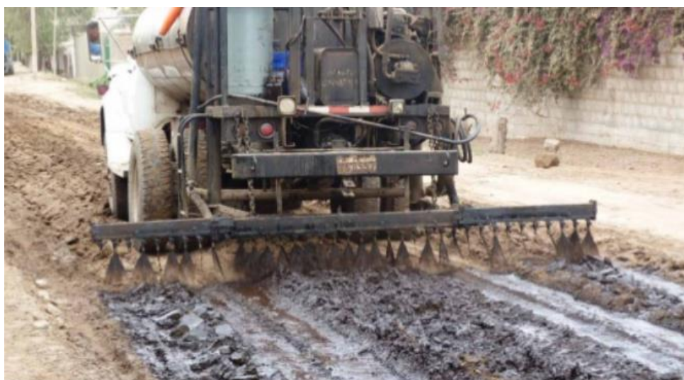
Ilustración 13: Estabilización con asfalto en campo
