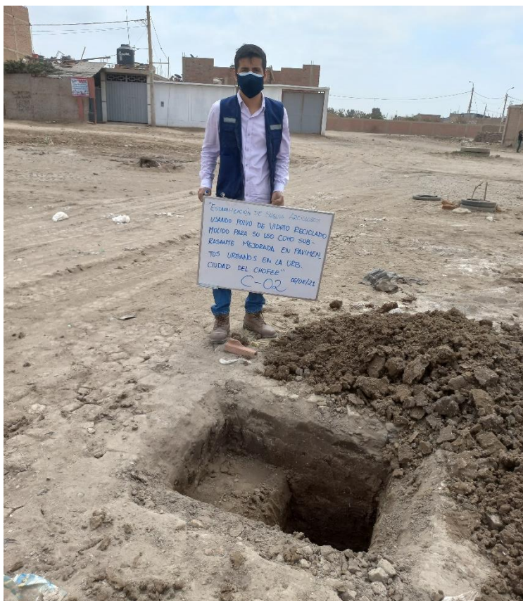
Ilustración 25: Zona de extracción de calicata N° 02 en Urb. Ciudad del Chofer
