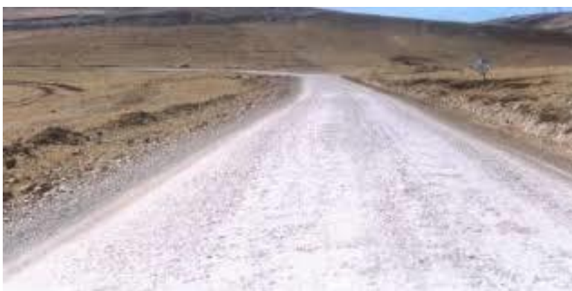
Ilustración 12: Estabilización con cloruro de sodio en campo
