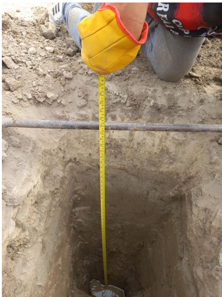
Identificación de nivel freático a 1.30 metros de profundidad en calicata N° 01
