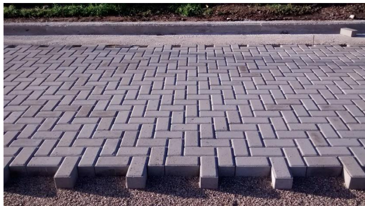
Ilustración 18: Estructura tradicional de pavimento adoquinado
