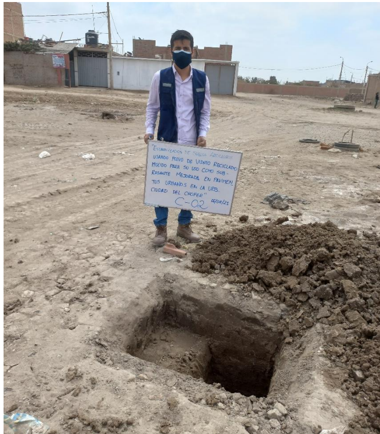
Extracción muestra de suelo de calicata N° 02 en Urb. Ciudad del Chofer
