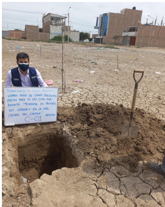
Extracción de muestra de suelo de calicata N° 01 en Urb. Ciudad del Chofer
