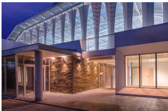
Figura 51- Estructura de acero. (Fuente: https://www.archdaily.pe )
