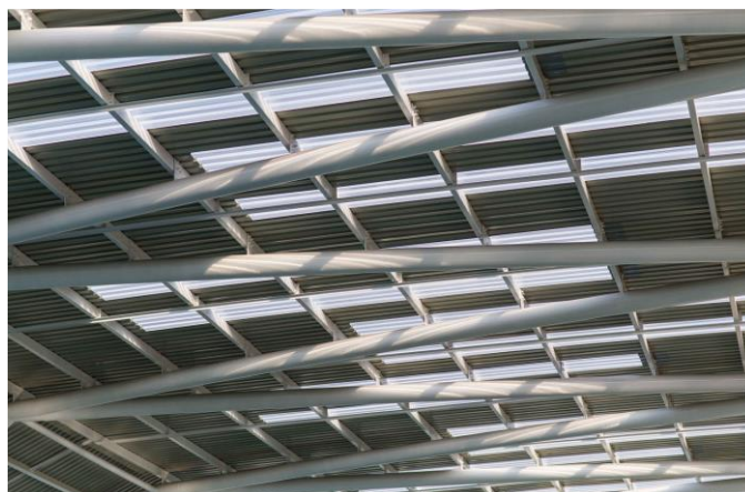
Figura 49 - Estructura de acero. (Fuente: Centro Acuático https://www.archdaily.pe )
