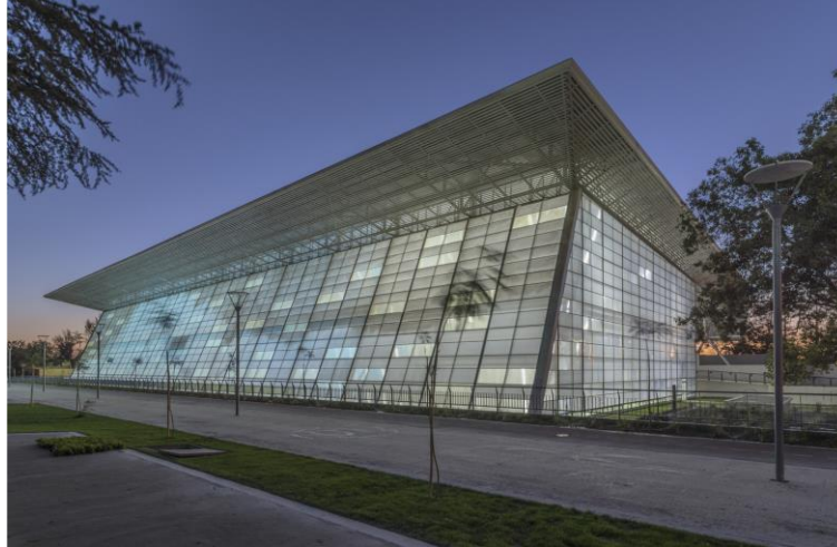
Figura 52- Estructura de Acero. (Fuente: https://www.archdaily.pe-Centro Acuático Nacional )
