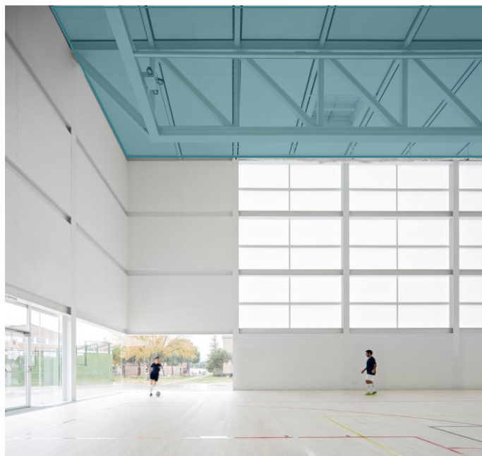
Figura 42- Estructura de acero pintada de blanco. (Fuente: https://www.archdaily.pe )
