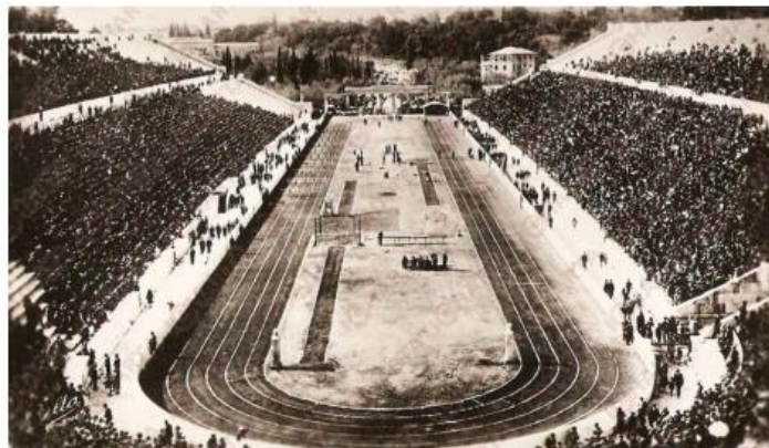
Figure 7- en 1896 - estadio de Atenas. (Fuente: Fernández A. (2017). Arquitectura deportiva Cubiertas simbólicas, experiencias memorables ).
