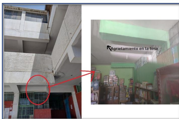
Figura 134: Junta de Módulo 3
