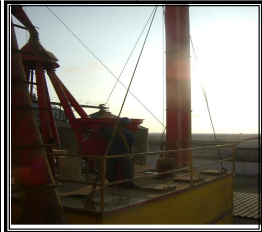
Figura N° 3.21. Montaje de la estructura
