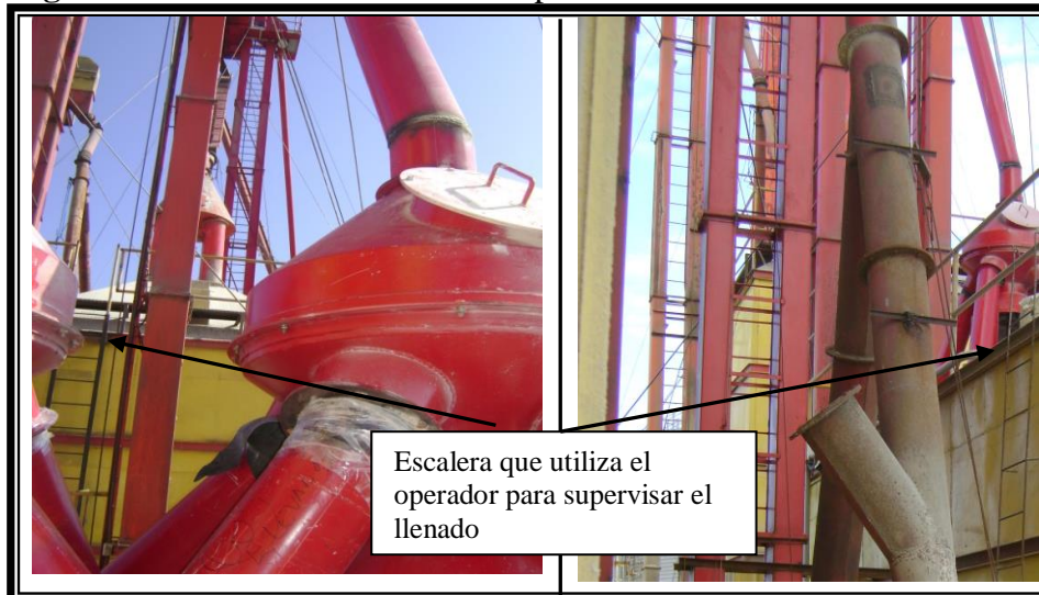
Figura N.º 3.8. Escalera de acceso a plataforma de tolvas.
