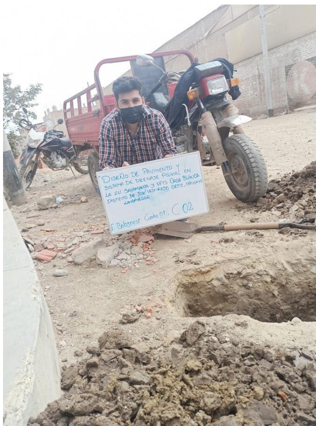
Fotografía 20 Calicata 02 Ca. Francisco Bolognesi cdra. 01
