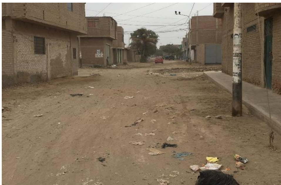
Fotografía 4 Situación actual de la Ca. Panamá
