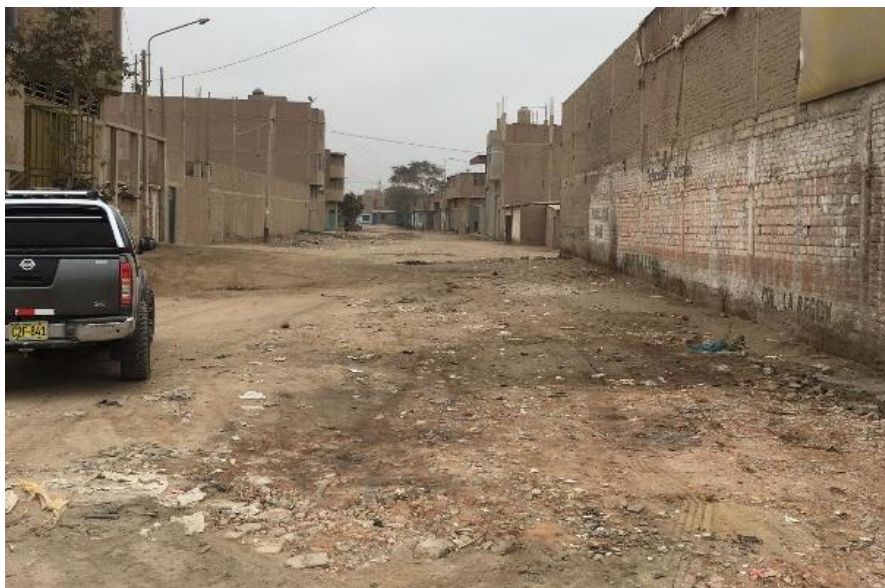
Fotografía 3 Situación actual de la Ca. Francisco Bolognesi
