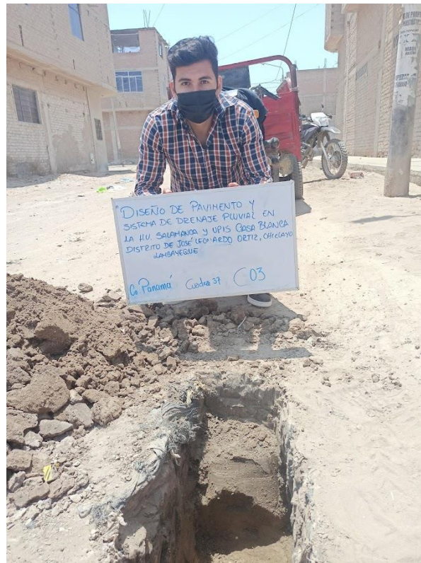
Fotografía 21 Calicata 03 Ca Panamá cdra. 37
