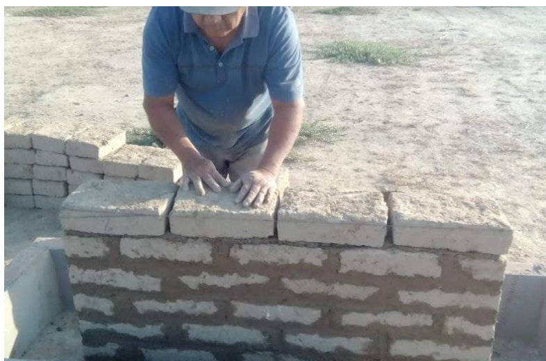
Fig. 116: Construcción de Muros de Adobe
