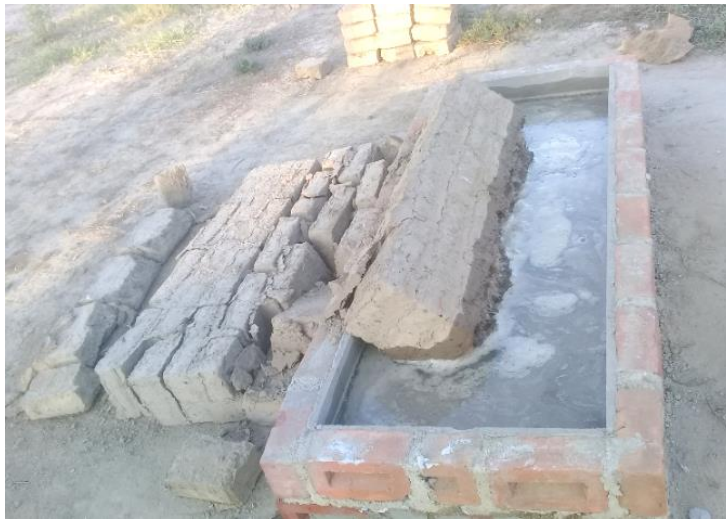
Fig. 120: Derrumbe de Muro Patrón El inició del ensayo inició el día 24 de mayo.
