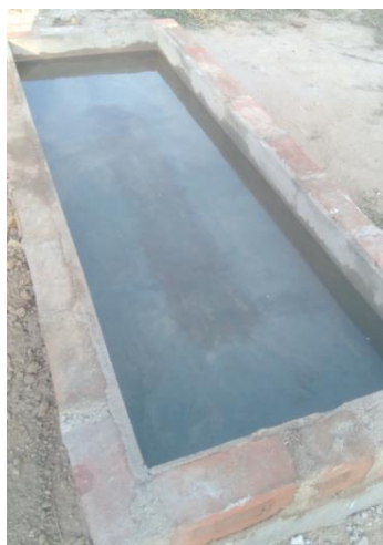
Fig. 115: Prueba de Estanqueidad
