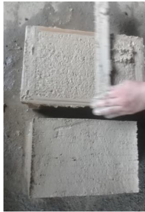
Fig. 67: Fabricación de Adobes de Prueba
