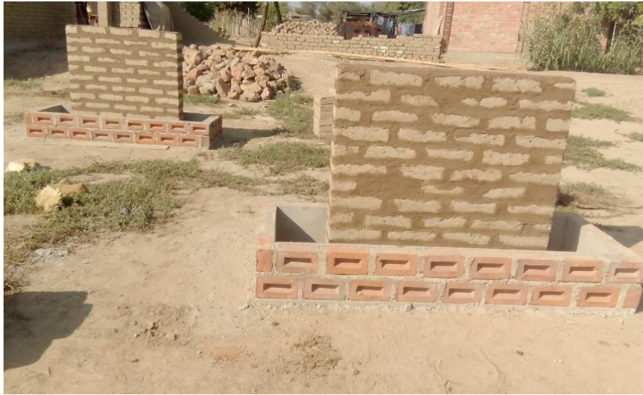
Fig. 117: Muros de Adobe
