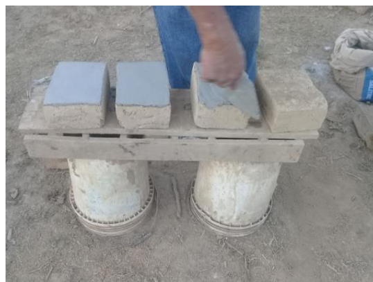
Fig. 73: Recubrimiento de la superficie del adobe
