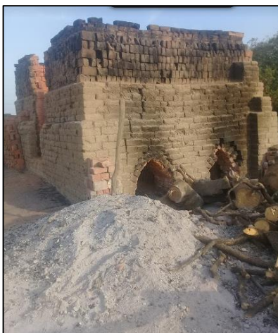
Fig. 125: Ladrillera artesanal Illimo
