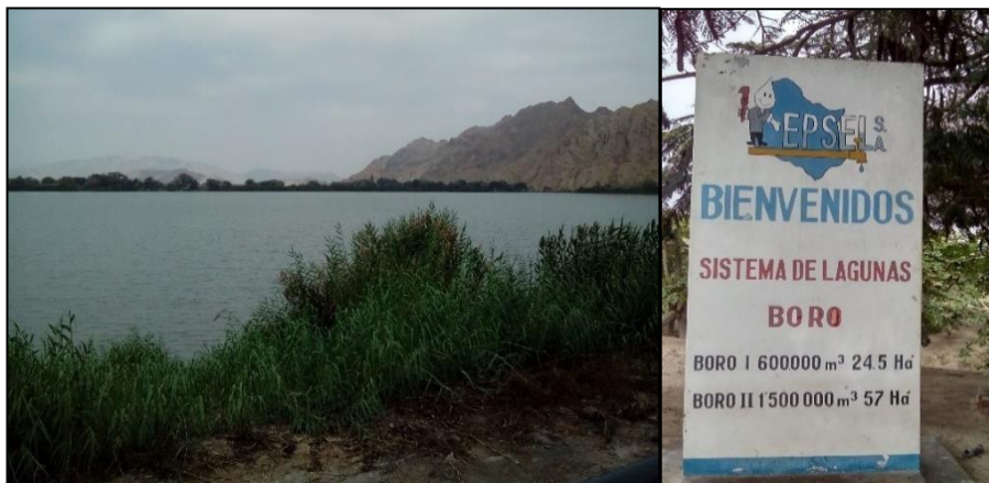
Figura 8: Sistema de almacenaje y pretratamiento - Lagunas Boro
