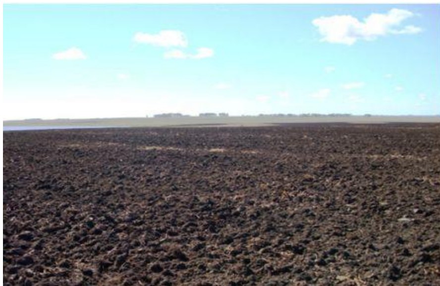
Figura 22: Nivelación de terreno con paletas jaladoras y planchadoras
