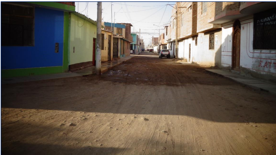
FOTOGRAFÍA N° 4.4: SITUACIÓN ACTUAL, A MARZO DEL 2018, DE LA CALLE AREQUIPA.
