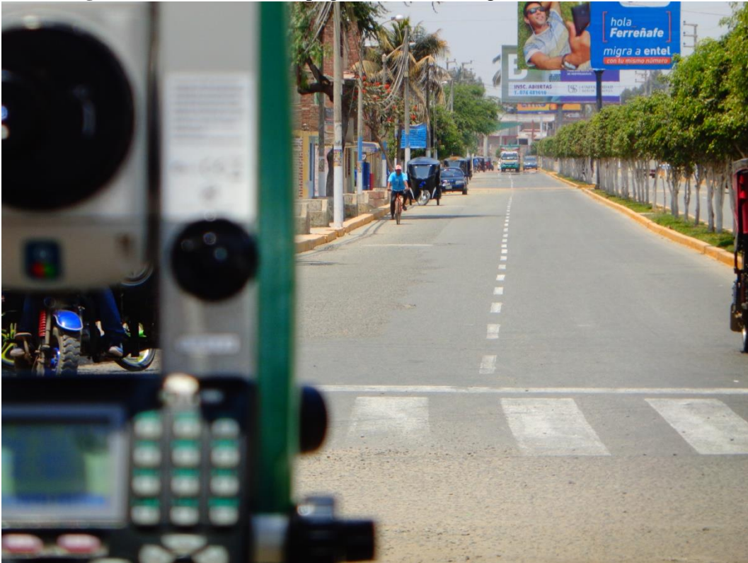
Fotografía N° 01: Estudio topográfico en Prolongación Nicanor Carmona
