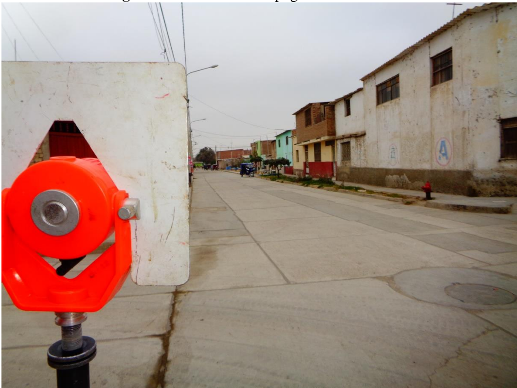
Fotografía N° 02: Estudio topográfico en Calle Santa Rosa
