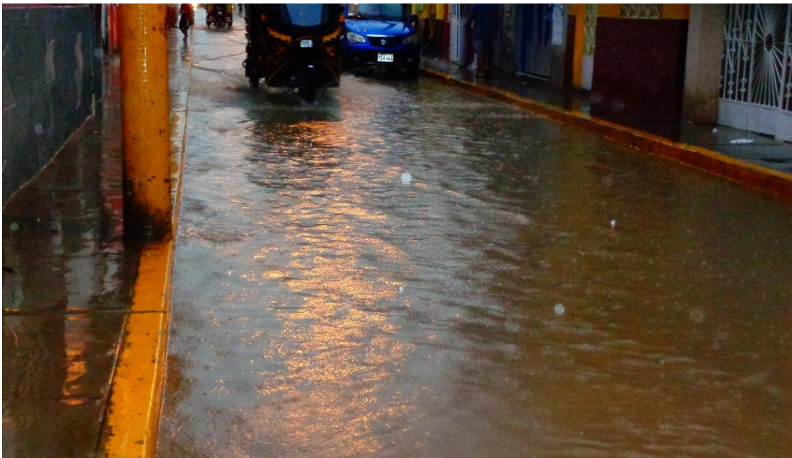
FOTOGRAFÍA 4.16: SITUACIÓN DE LA CALLE UNIÓN DURANTE EL FENÓMENO DEL “NIÑO COSTERO”.
