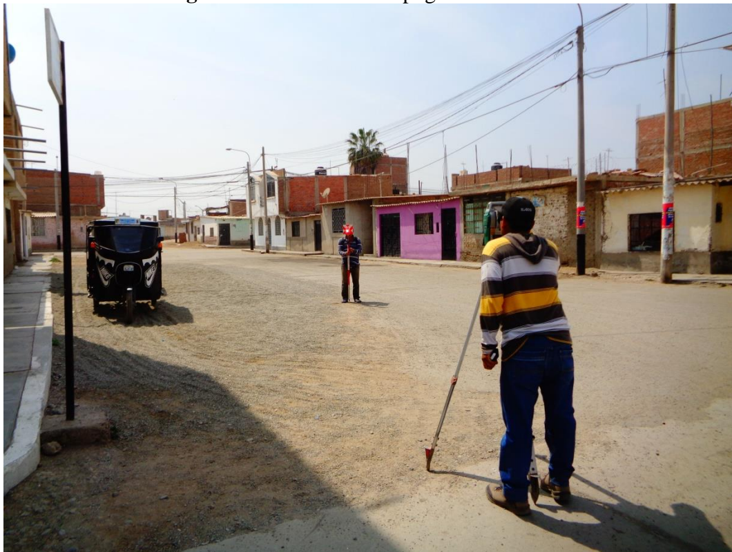
Fotografía N° 04: Estudio topográfico en Calle Ilo
