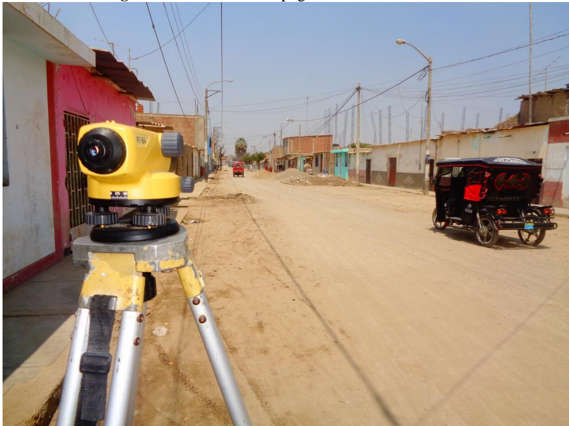
Fotografía N° 06: Estudio topográfico en Calle Tres Marías
