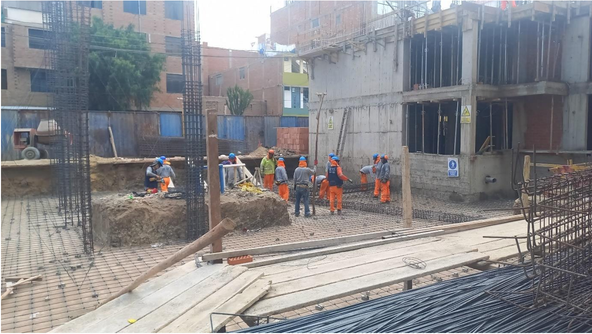
Ilustración 34. Cuadrilla de ejecución de acero en cimentación
