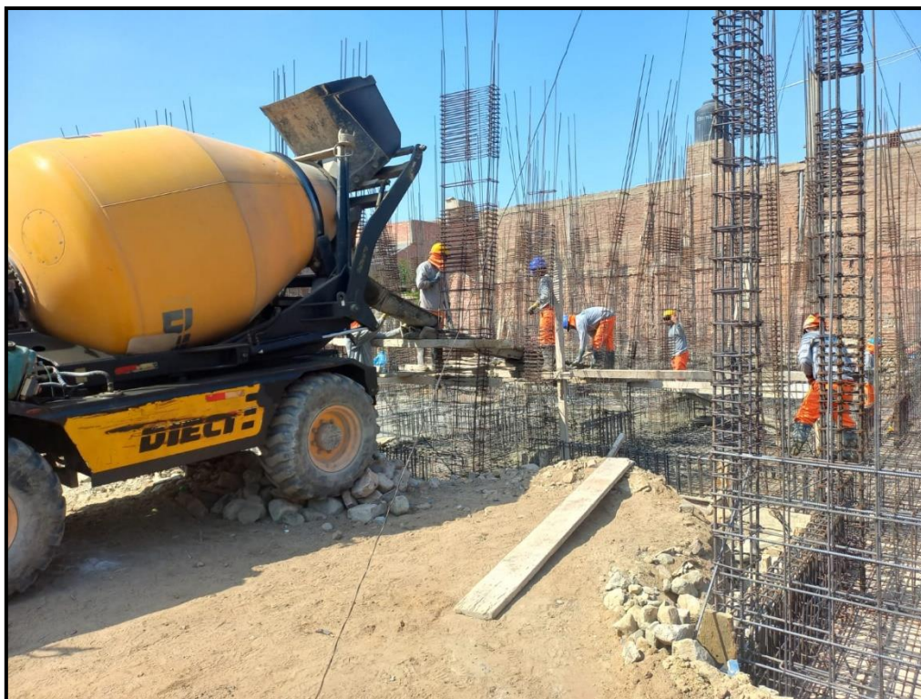
Ilustración 19. Ejecución de partida de cimentación
