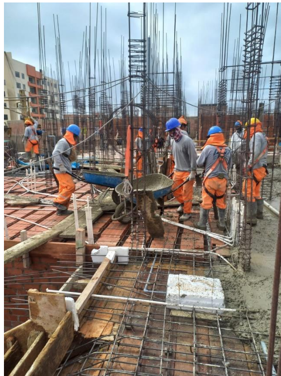
Ilustración 33. Vaciado de losa aligerada Block A1
