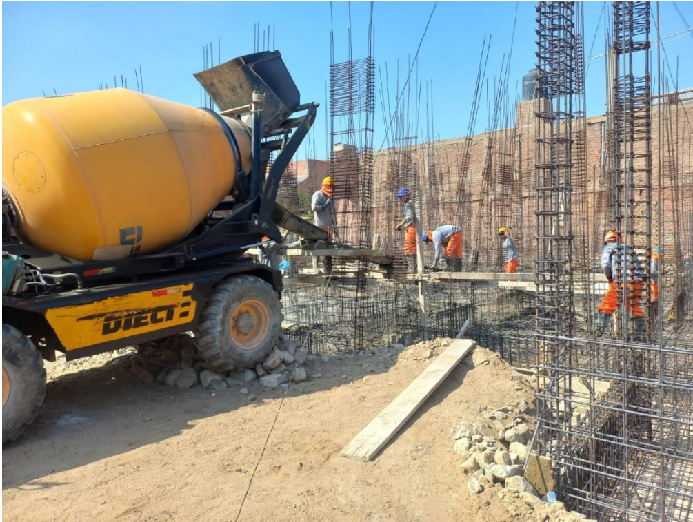
Ilustración 32. Vaciado de platea de cimentación Block A1
