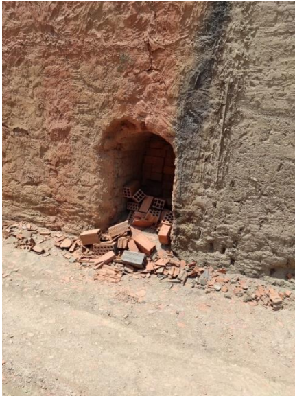
Anexo N°1.2 Residuos de ladrillo por mal proceso de cocción.
