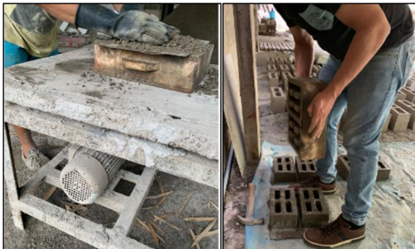
Ilustración 7: Vibración y desmolde de unidades de albañilería de concreto tipo 10
