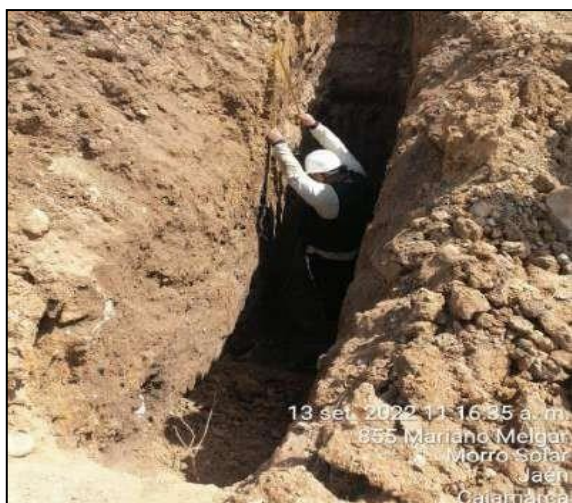
Figura 8. Calicatas realizadas en el asentamiento humano “Sol Naciente”. Fuente: Elaboración Propia.
