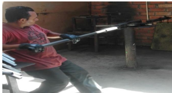
Figura N°07. Doblado de los tubos
