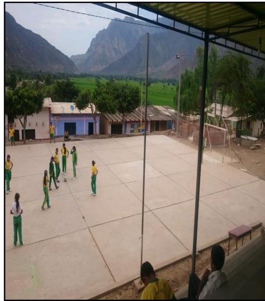
Inexistencia de baranda en la pirca
