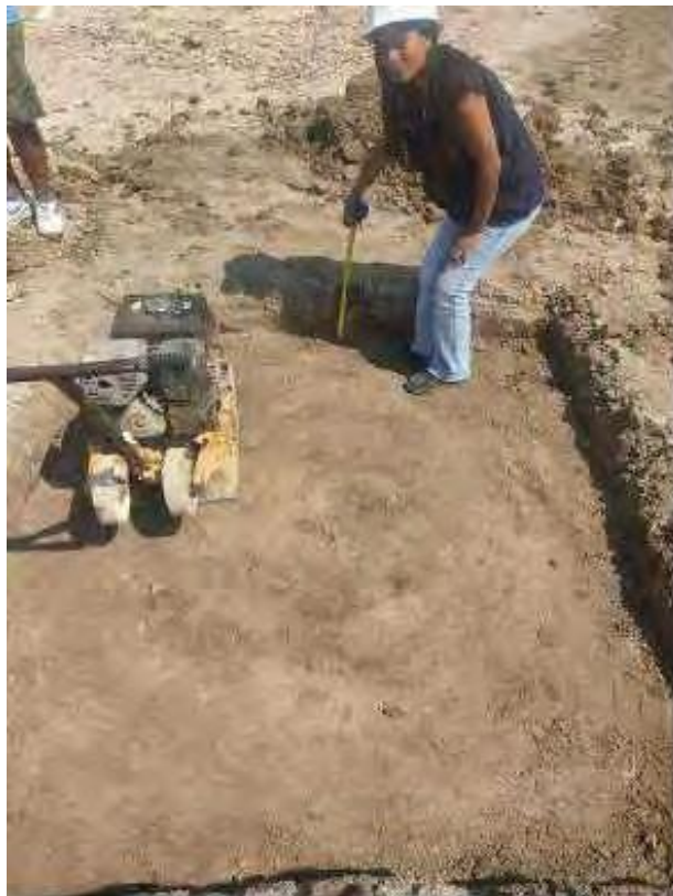
Figura 21: Compactación por capas del suelo natural + arena de mar
