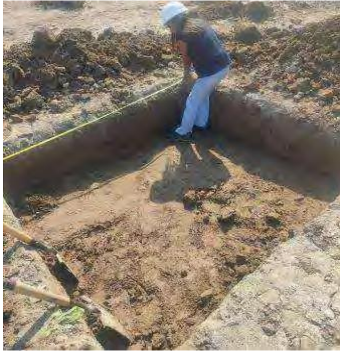
Figura 20: Realización del ensayo Densidad de campo.
