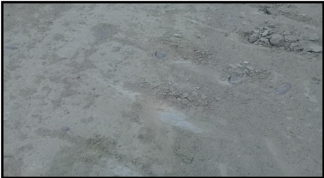
Ilustración 2. Suelo de carretera
