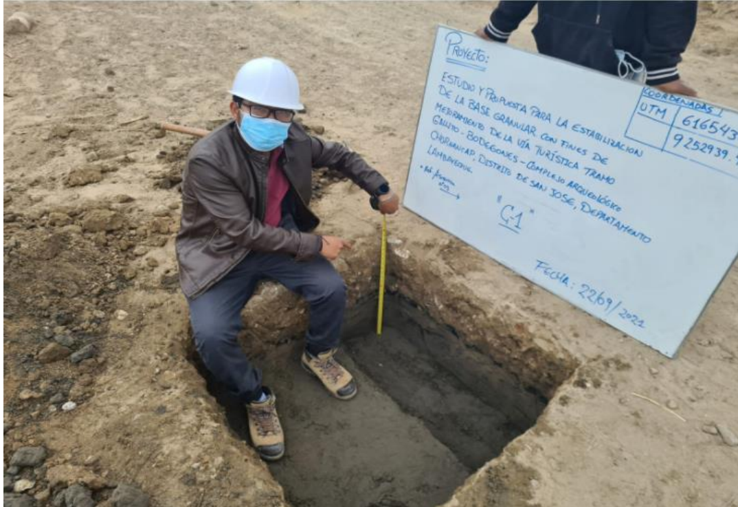
Ilustración 110 Extracción de Calicatas
