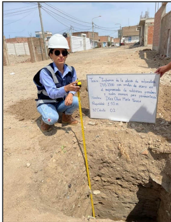
Ilustración 3: Zona de extracción – C2
