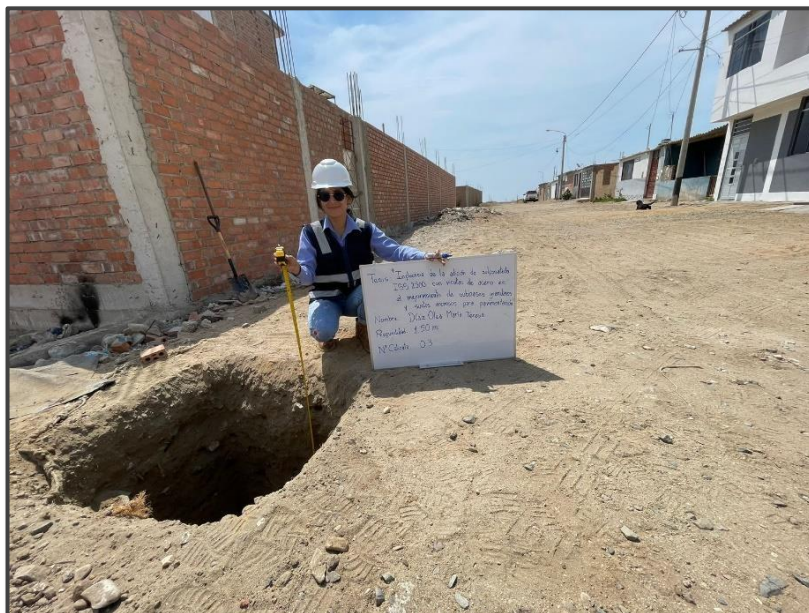
Ilustración 5: Zona de extracción – C3
