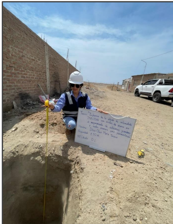
Ilustración 4: Zona de extracción – C1
