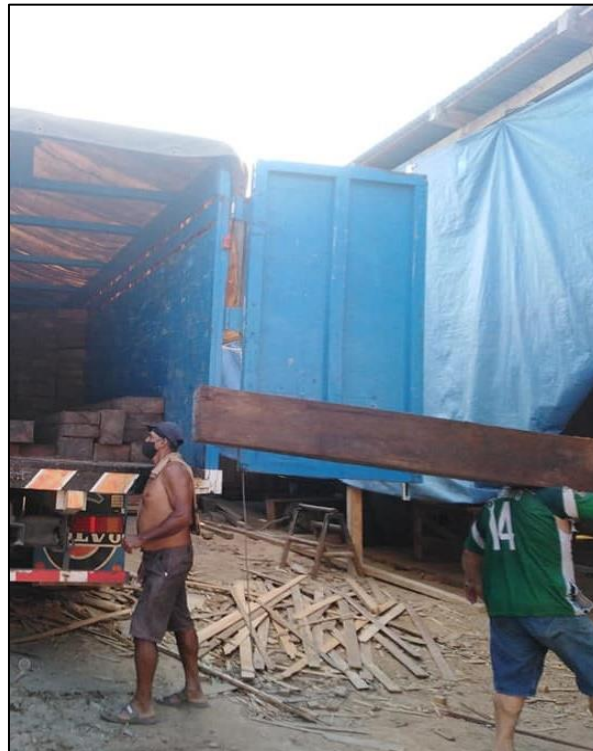
Procedimiento inadecuado para la carga de madera
