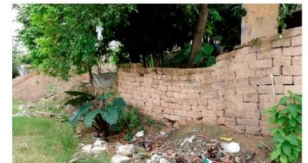
Viviendas en mal estado
