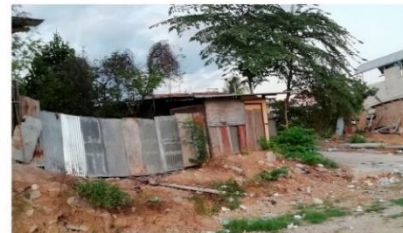
Viviendas en estado regular
