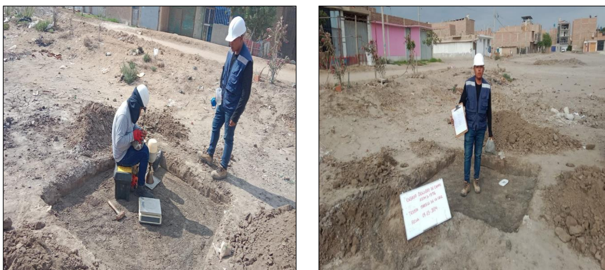
Figura N° 40. Densidad de campo del tramo de prueba
