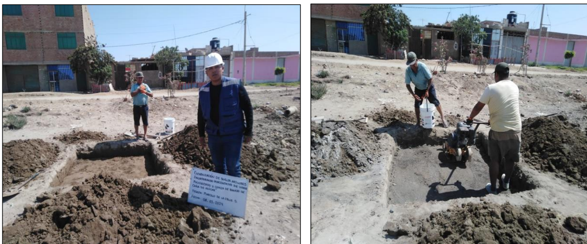
Figura N° 39. Nivelación y compactación del tramo de prueba
