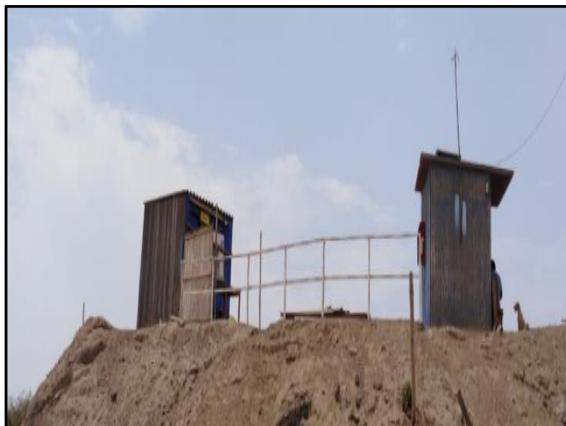
Figura 41: Casetas de seguridad en la escombrera
