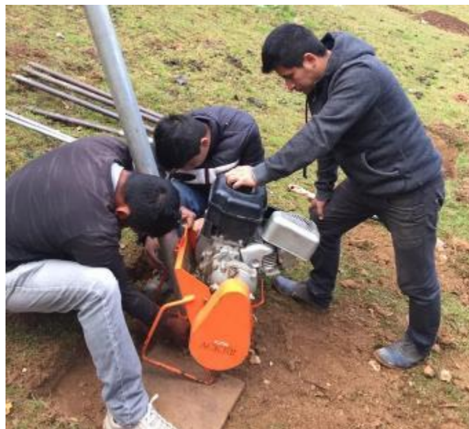
FOTOGRAFÍA N° 12: COLOCACIÓN DEL MOTOR PARA EL CORRECTO FUNCIONAMIENTO DEL SPT.
