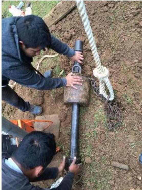
FOTOGRAFÍA N°11: COLOCACIÓN DEL MARTILLO A LA CAÑA PARA EL HINCAMIENTO DEL SUELO.
