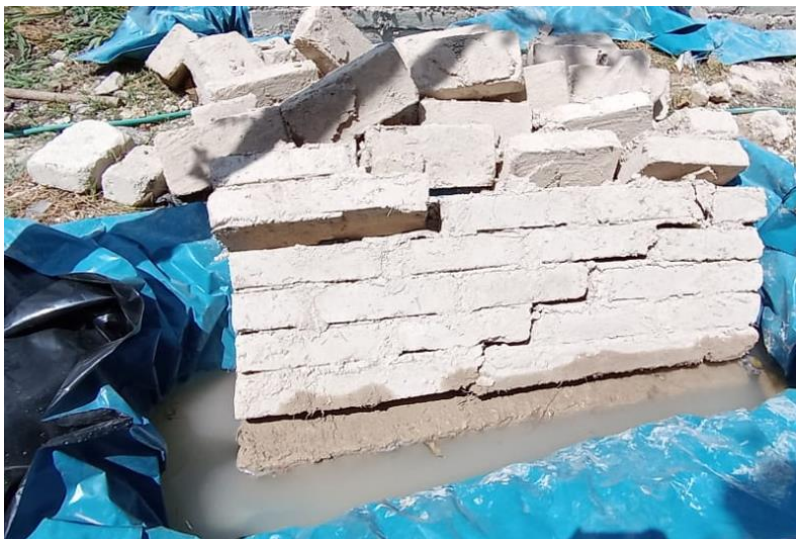
Ilustración 51: Desplome del muro de bloques de tierra patrón
