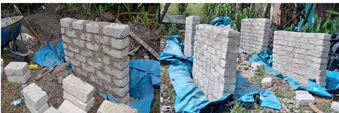
Ilustración 48: Construcción de los muros patrón y estabilizados al 3%, 5% y 8%
