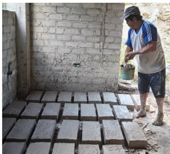
Ilustración 28: Curado de los bloques de tierra estabilizados
