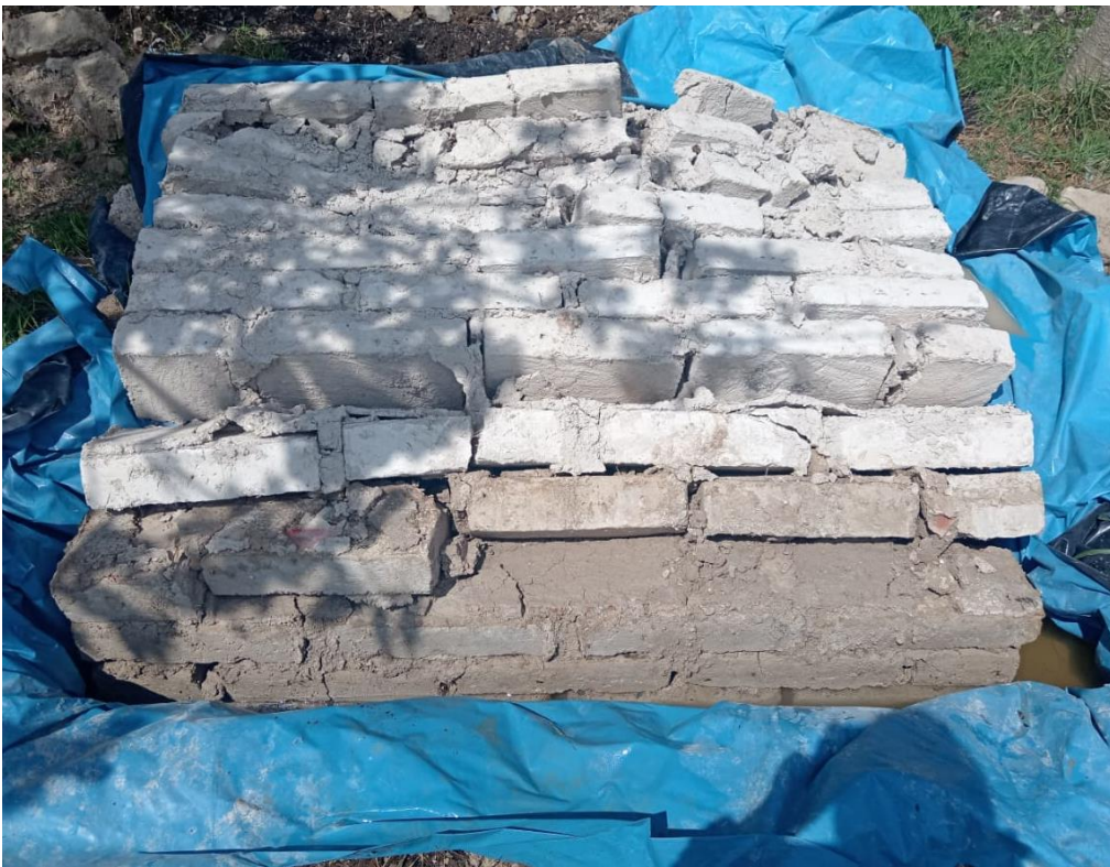
Ilustración 55: Desplome del muro estabilizado con 8% de cemento
