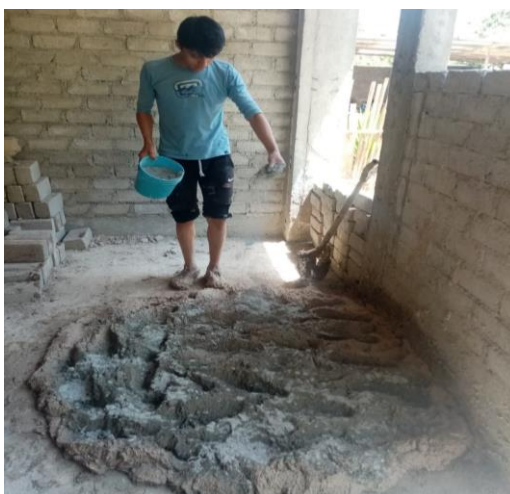
Ilustración 26: Preparación de la mezcla para la elaboración de bloques de tierra estabilizados
