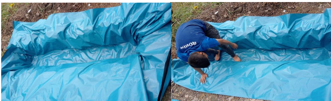
Ilustración 47: Pozas impermeabilizadas para simulación de inundación
