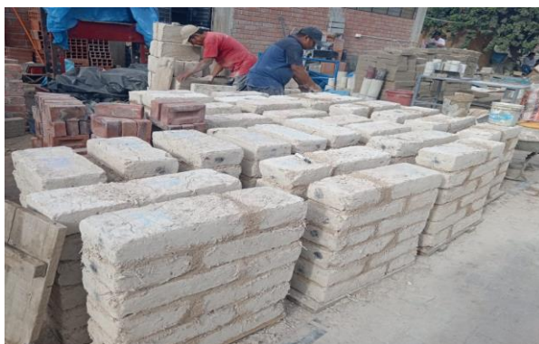
Ilustración 45: Ensayo de Resistencia del murete a la tracción - elaboración de muros
