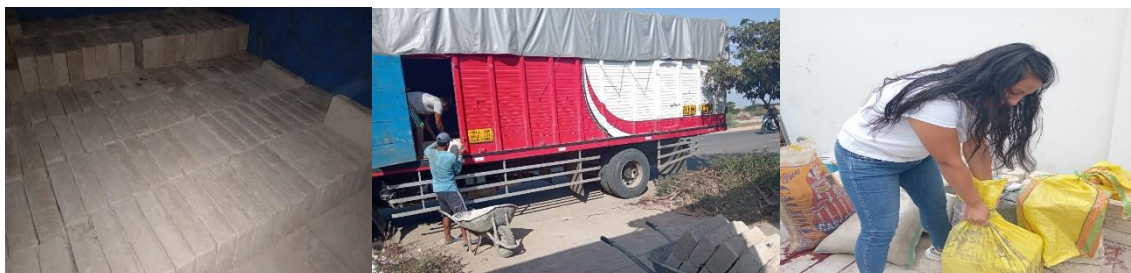
Ilustración 29: Transporte de los bloques de tierra
