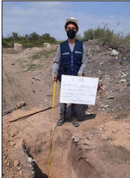
Fotografía N° 13: Excavación de Calicata N° 01
