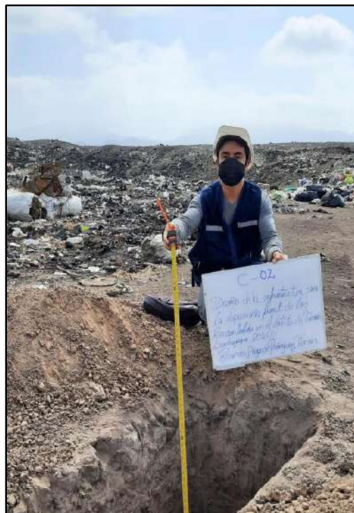
Fotografía N° 14: Excavación de Calicata N° 02
