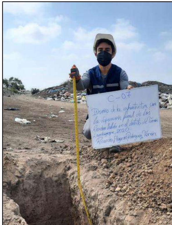
Fotografía N° 19: Excavación de Calicata N° 07
