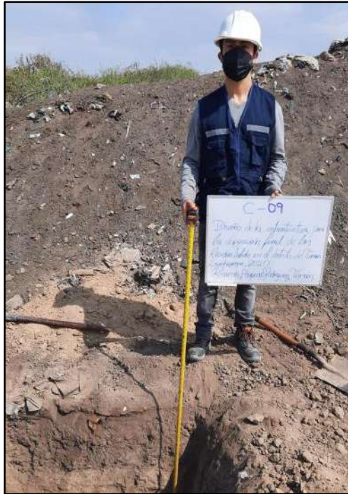
Fotografía N° 21: Excavación de Calicata N° 09
