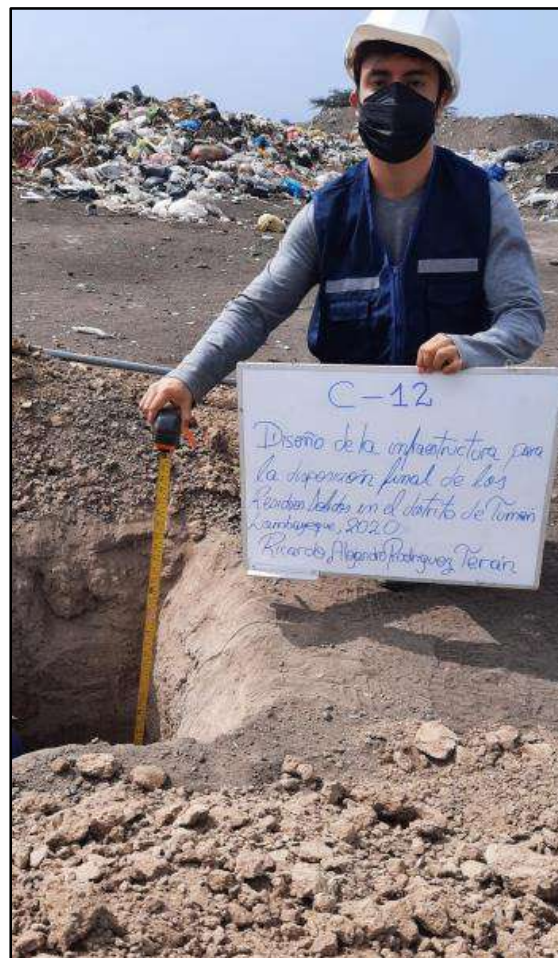
Fotografía N° 24: Excavación de Calicata N° 12
