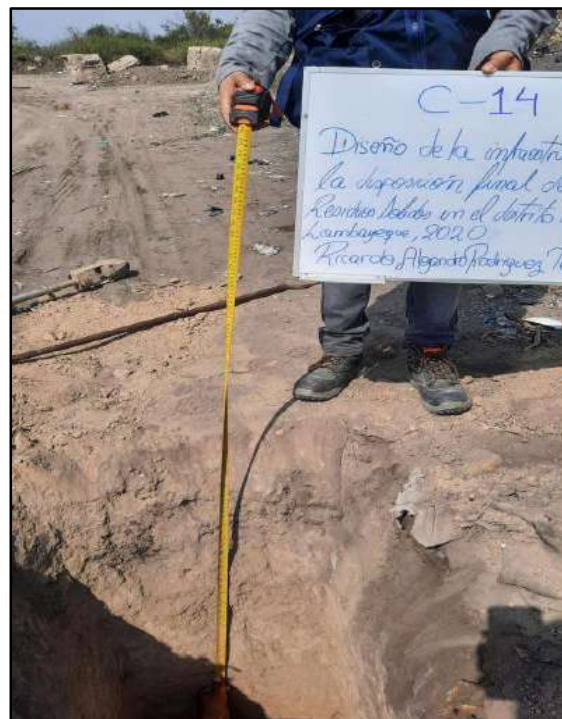
Fotografía N° 26: Excavación de Calicata N° 14
