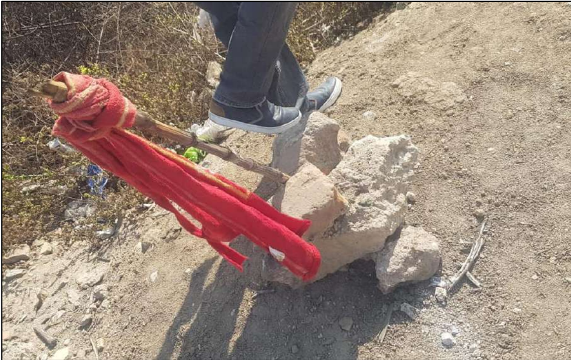
Fotografía N° 11: Marcado de BMS para replanteo del Levantamiento Topográfico
