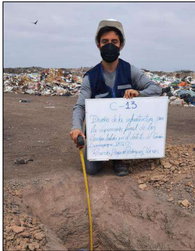
Fotografía N° 25: Excavación de Calicata N° 13
