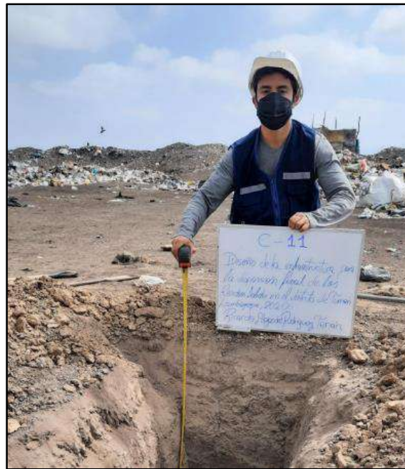
Fotografía N° 23: Excavación de Calicata N° 11
