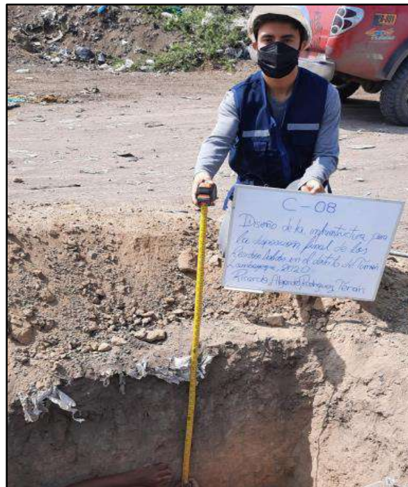
Fotografía N° 20: Excavación de Calicata N° 08
