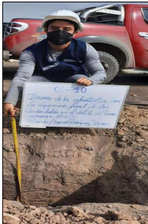
Fotografía N° 22: Excavación de Calicata N° 10
