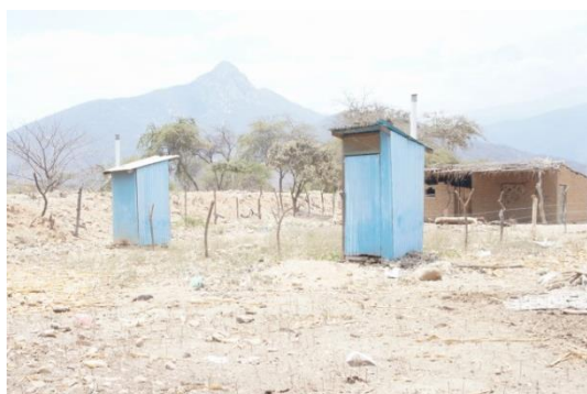
Fig 68: Foto servicios higiénicos típico (letrinas). Fuente: Toma propia.
