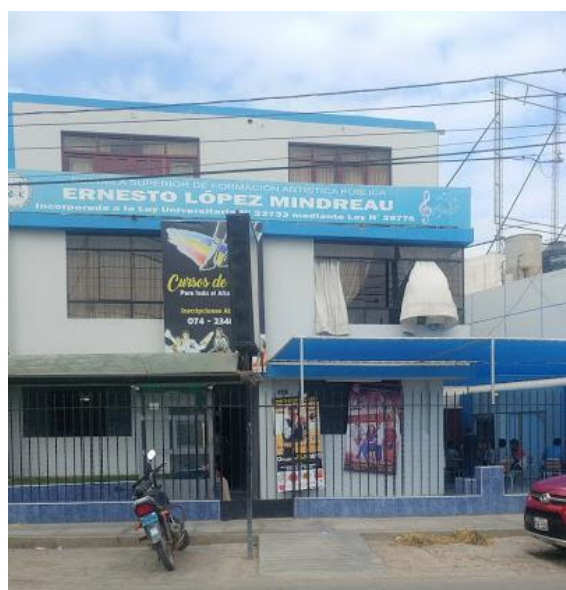
Imagen 27: Fachada principal de la ESFAP
