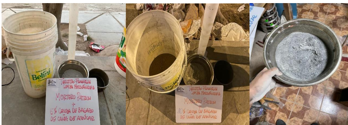
Imagen 21 Materiales listos para elaborar mortero
