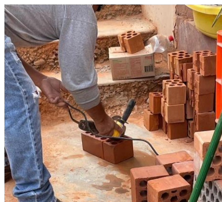
Imagen 49 Realización del corte del ladrillo
