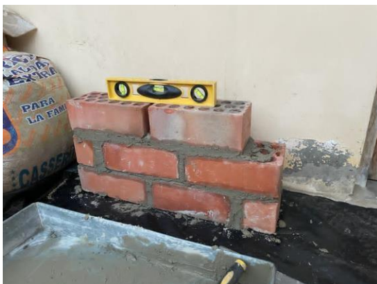
Imagen 48 Verificando la nivelación del murete
