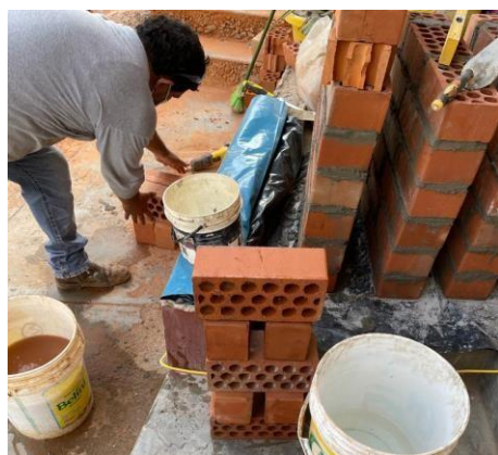
Imagen 50 Humedeciendo el ladrillo antes de asentarlo
