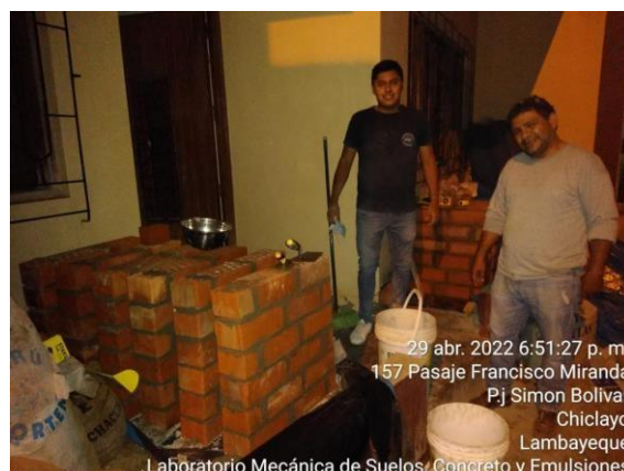
Imagen 51 Finalización de elaboración de muretes
