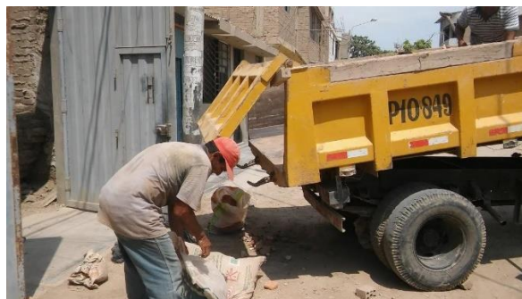
Figura n° 9. 9. "Transporte del material a la chancadora Piedra Azul S.A"
