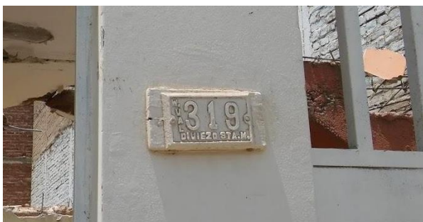
Figura n° 9.4. "Demolición calle Wilfredo Valdiviezo 319"
