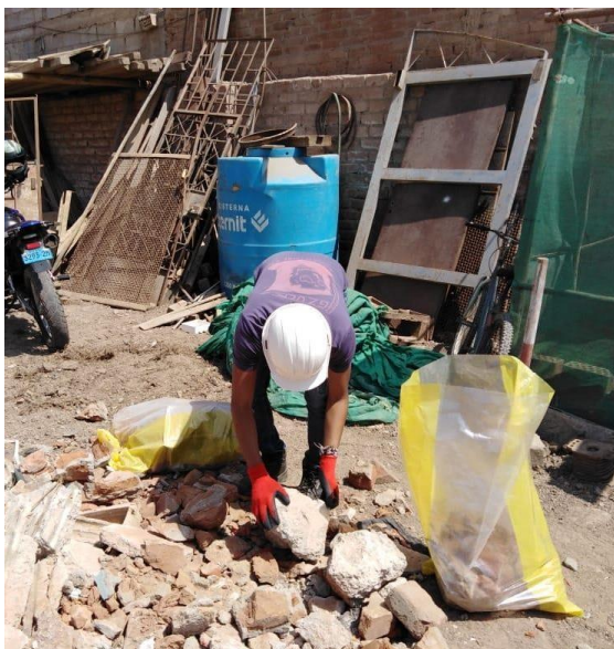
Figura n° 9. 8."Elección de la muestra a demoler"
