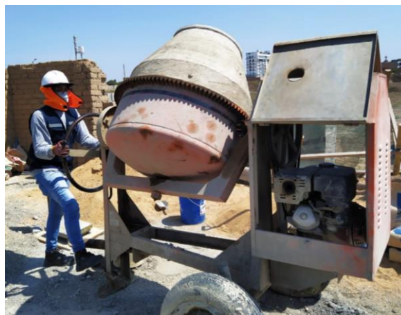
Figura n° 9. 57. Elaboración de la mezcla
