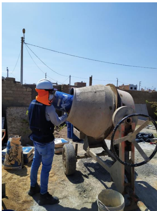
Figura n° 9. 55. Colocación de los agregados en el trompo
