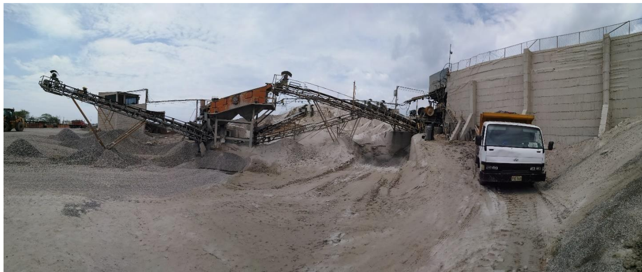
Figura n° 9. 12. Chancadora, proceso de chancado
