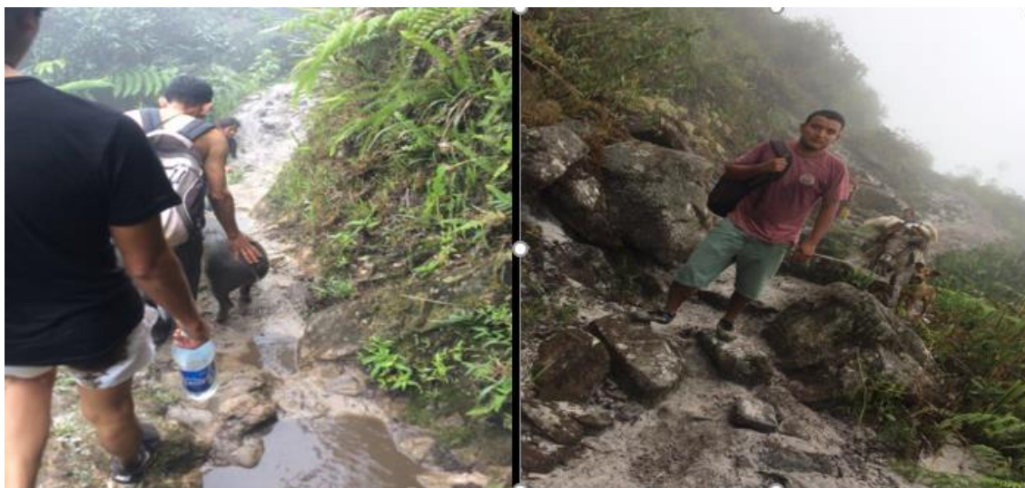
Fotografía N°: 5 Estado superficial del camino de herradura existente.
