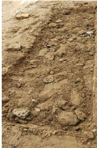
Figura 53. Relleno y conformación de subrasante mediante muestra estabilizada bajo 3 era adición.
