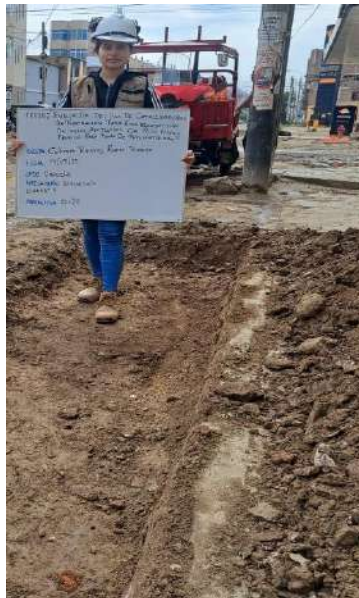
Figura 51. Habilitación de subrasante para tramo de prueba experimental.
