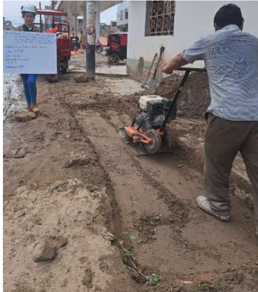
Figura 54. Compactación de subrasante por capas en tramo de prueba experimental.
