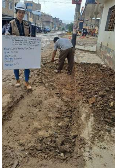
Figura 50. Excavación de subrasante para tramo de prueba experimental.
