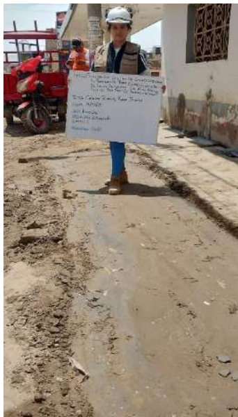
Figura 55. Subrasante compactada para tramo de prueba experimental.
