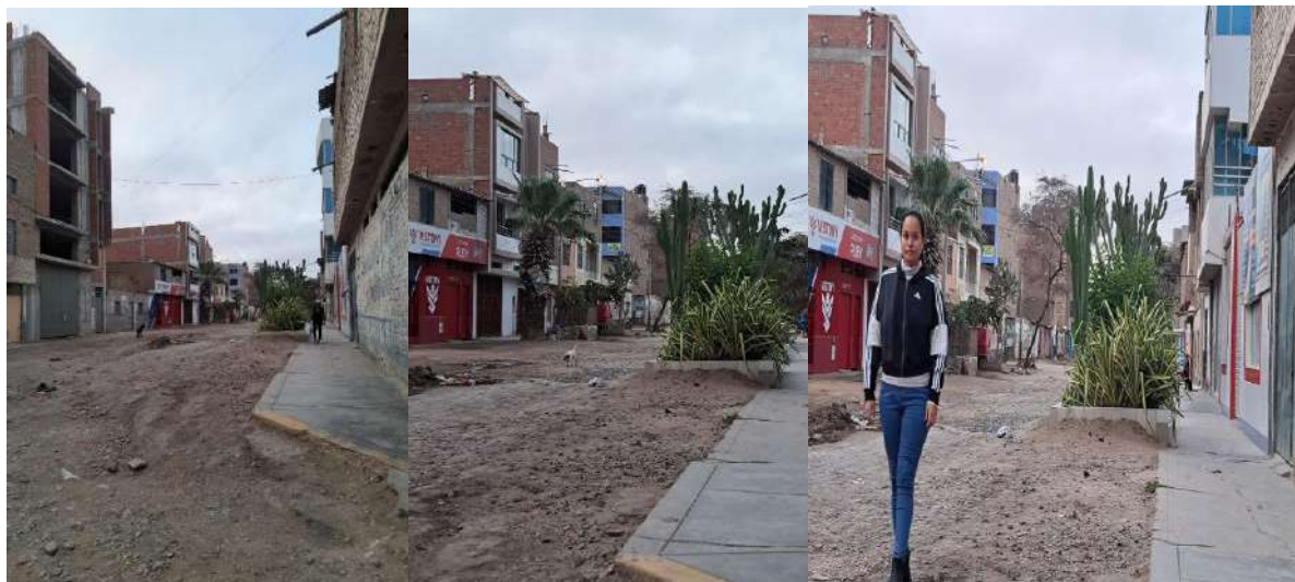
Figura 3. Encalaminado y pésimo estado de las vías en DJLO – Intersección Av. México con calle Atahualpa cuadra N° 09.
