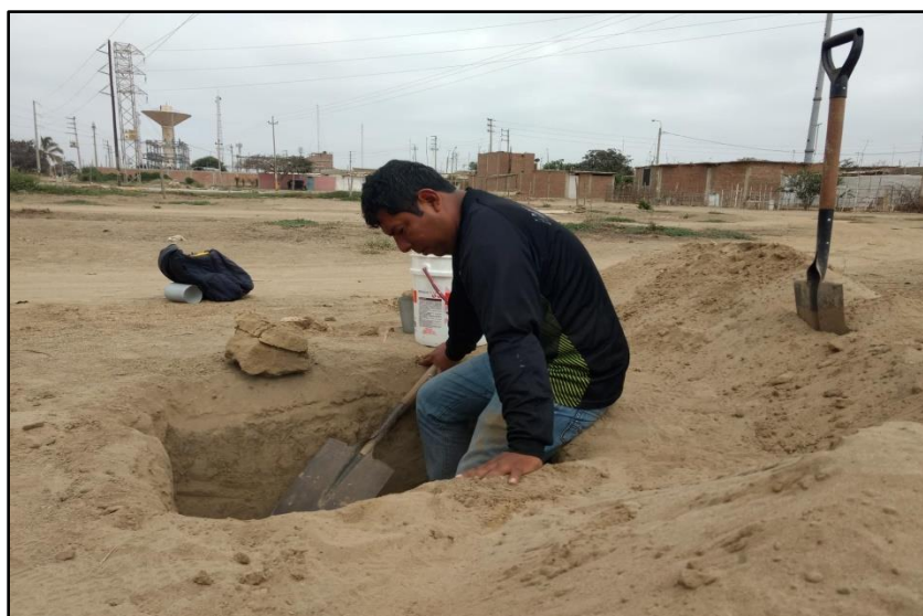
Figura N° 138. Calicatas para Extracción de Muestras de Suelo, profundidad 1.80 m.
