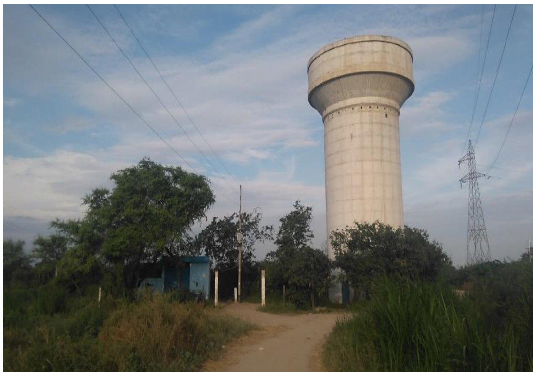
Figura N° 129. Visita a la Caseta de Bombeo y Reservorio
