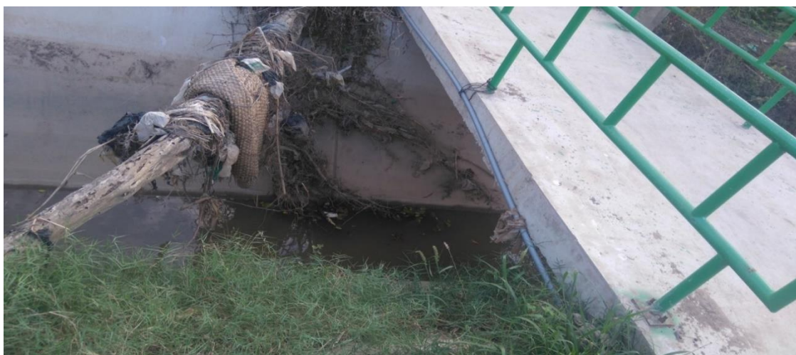
Figura N° 132. Canal de Derivación de las Aguas de las Lagunas de Oxidación Durante las Lluvias
