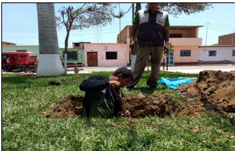
Figura N° 139. Trabajadores de la Municipalidad de Íllimo Apoyo para Excavación de Calicatas-
