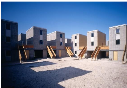
Imagen 10: Foto del conjunto habitacional. Fuente: sitio web archdaily
