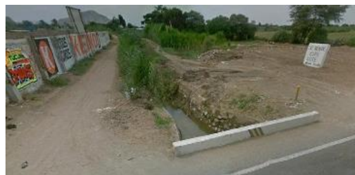
Ilustración 47 Dren ubicado en el sur. Fuente: Elaboración propia.
