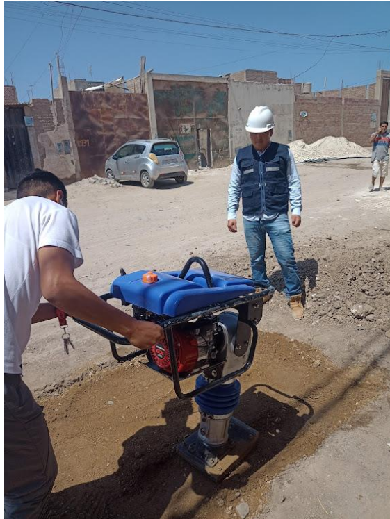
Figura 23. Compactación en tramo experimental.
