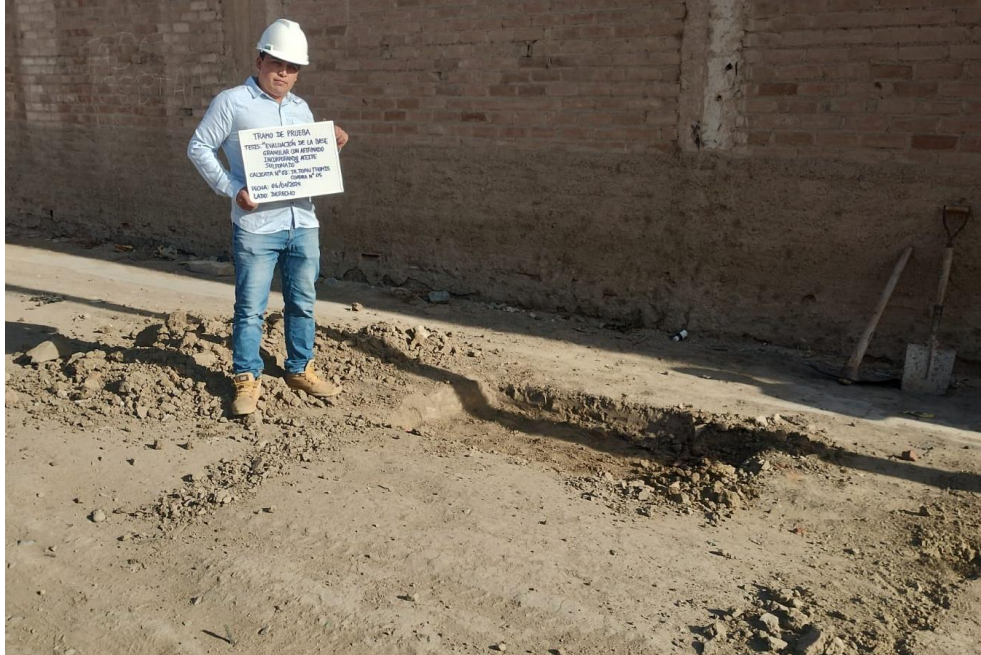
Figura 17. Excavación para tramo de prueba experimental.
