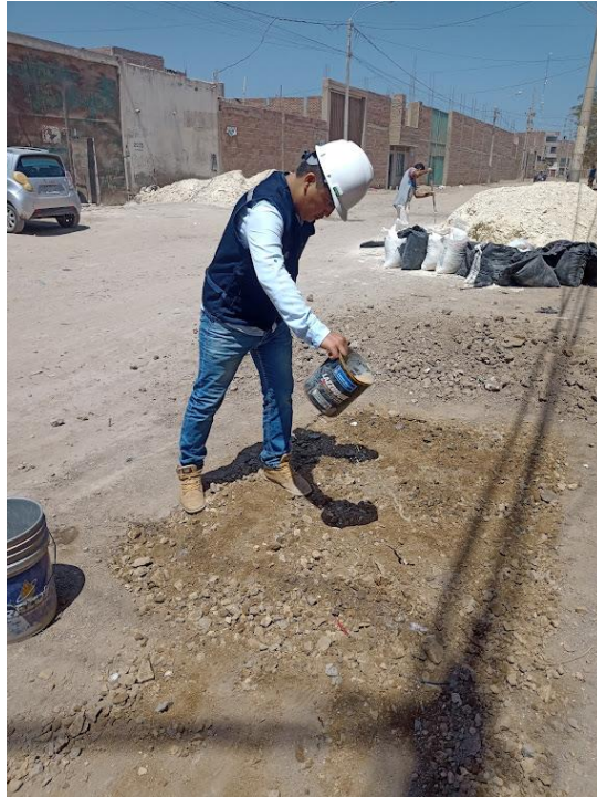
Figura 21. Incorporación de aceite sulfonado en tramo experimental.
