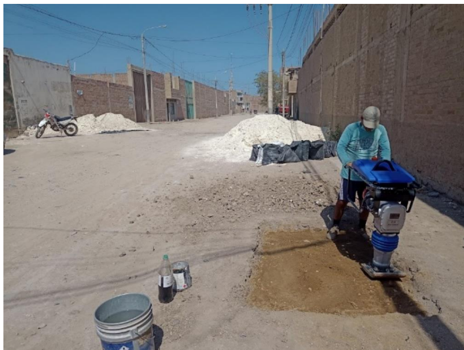
Figura 20. Aplanamiento en tramo experimental.
