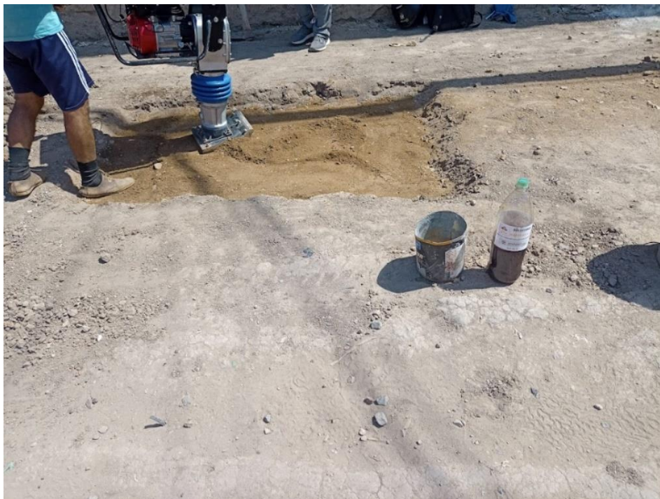
Figura 19. Nivelación en tramo experimental.
