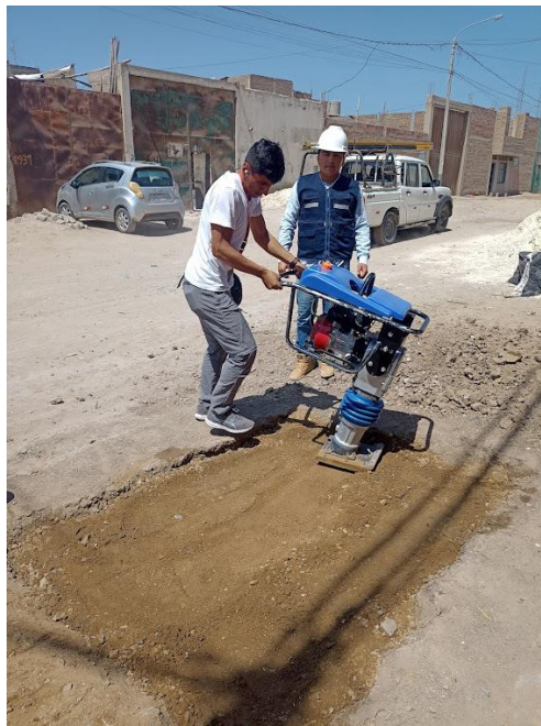
Figura 24. Compactación por capas en tramo experimental.
