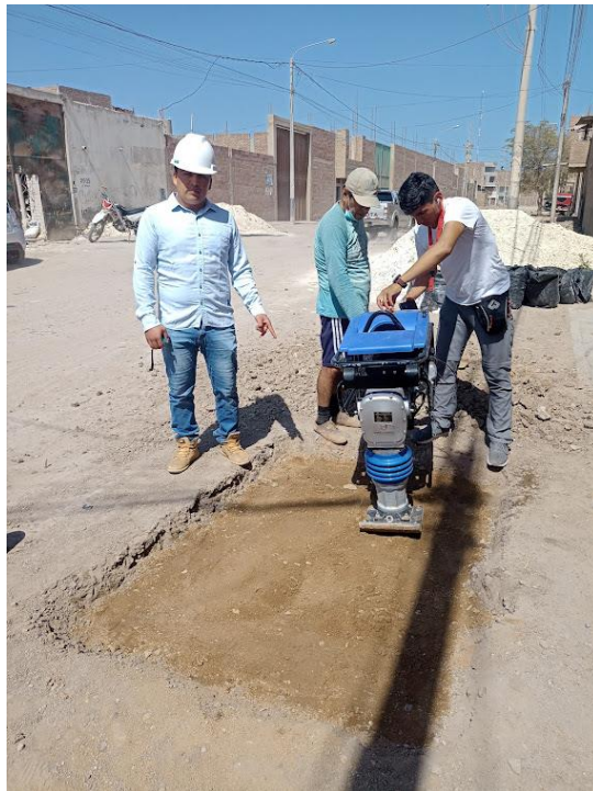
Figura 22. Compactación con afirmado en tramo experimental.
