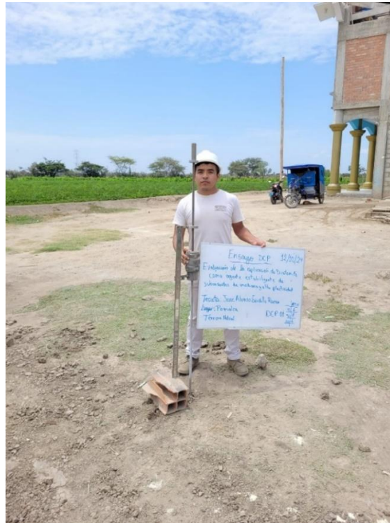
Fotografía 14: Realización de ensayo DCP en campo
