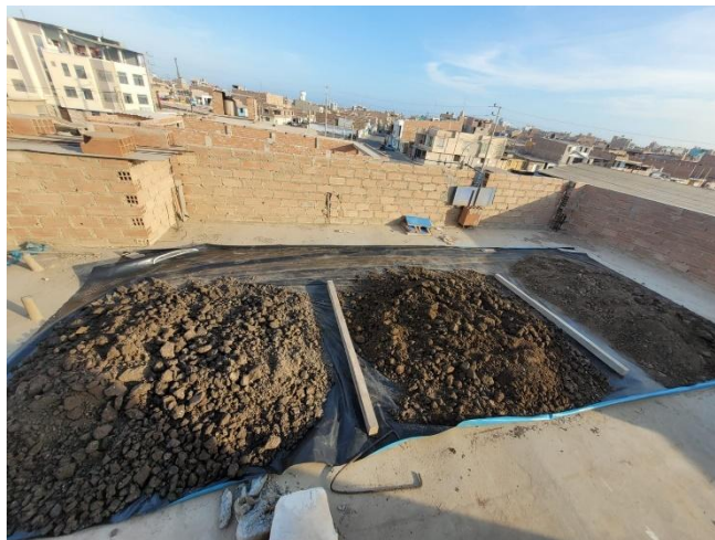
Fotografía 10: Secado de suelo para ensayo de Proctor Modificado
