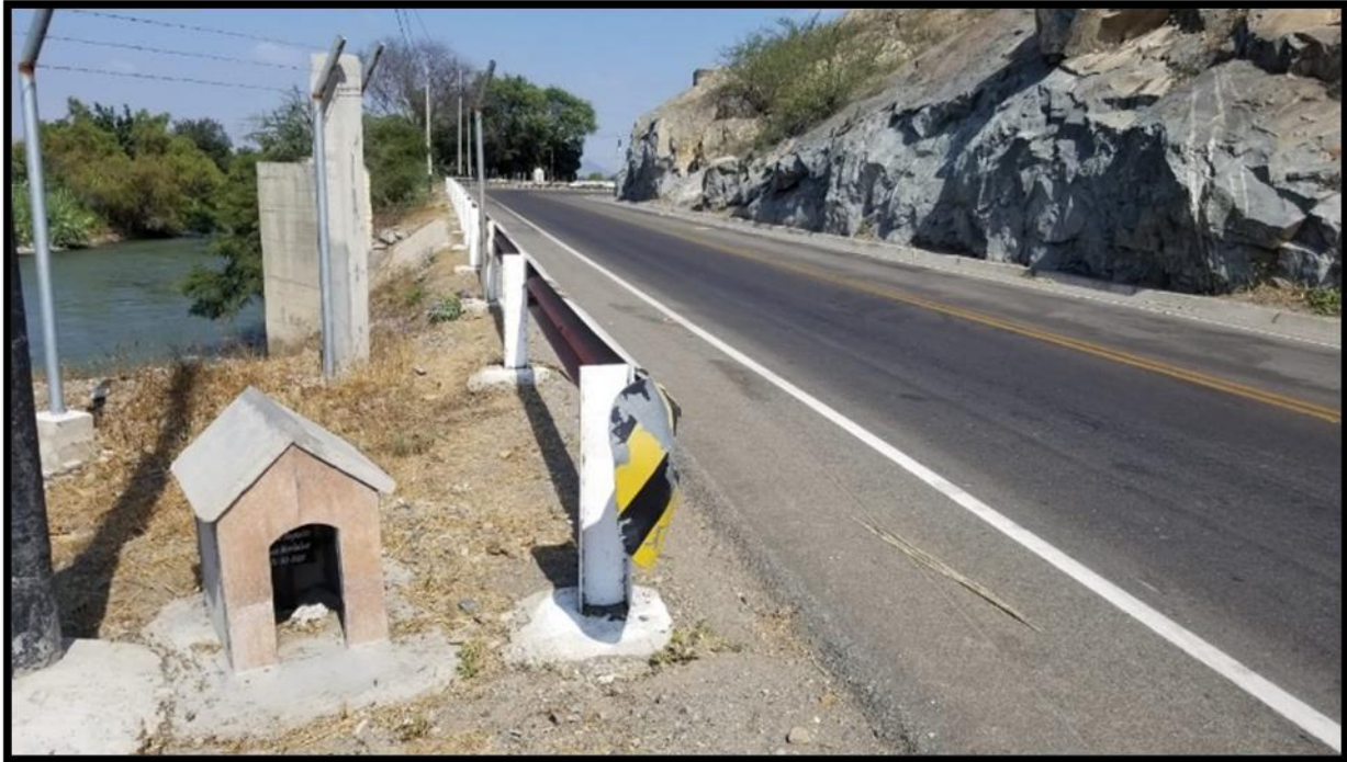
Imagen 13: Referencia a accidente de tránsito ubicado al costado de la carretera (Entre Km 45+000 y Km 46+000)
