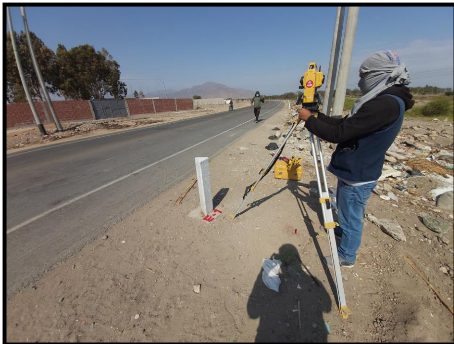
Imagen 52 Levantamiento topográfico de sectores críticos (Estación 1-Sector II)
