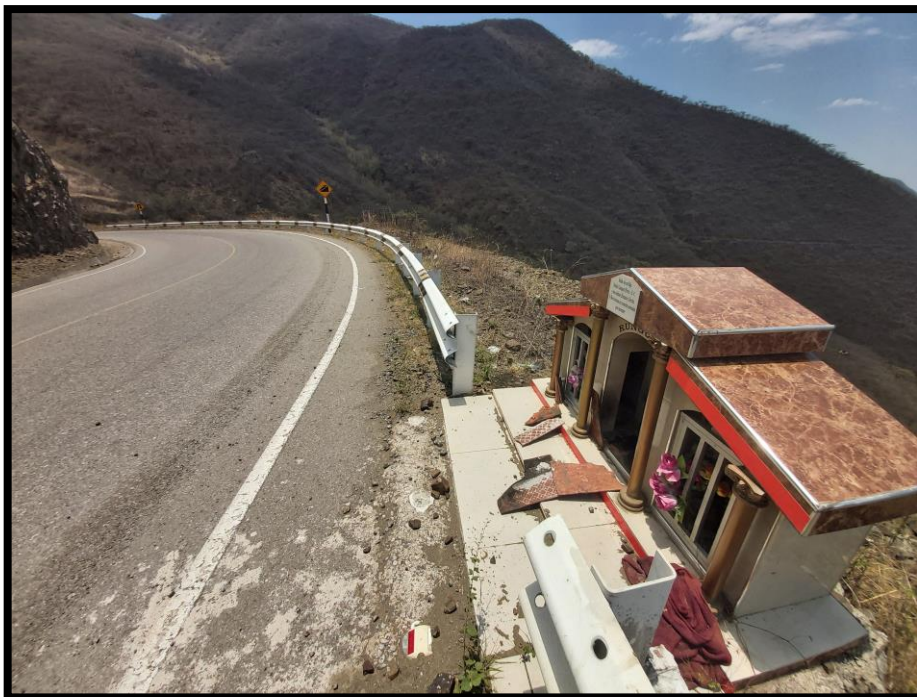
Imagen 36: Referencia a accidente de tránsito ubicado al costado de la carretera (Entre Km 107+000 y Km 108+000)
