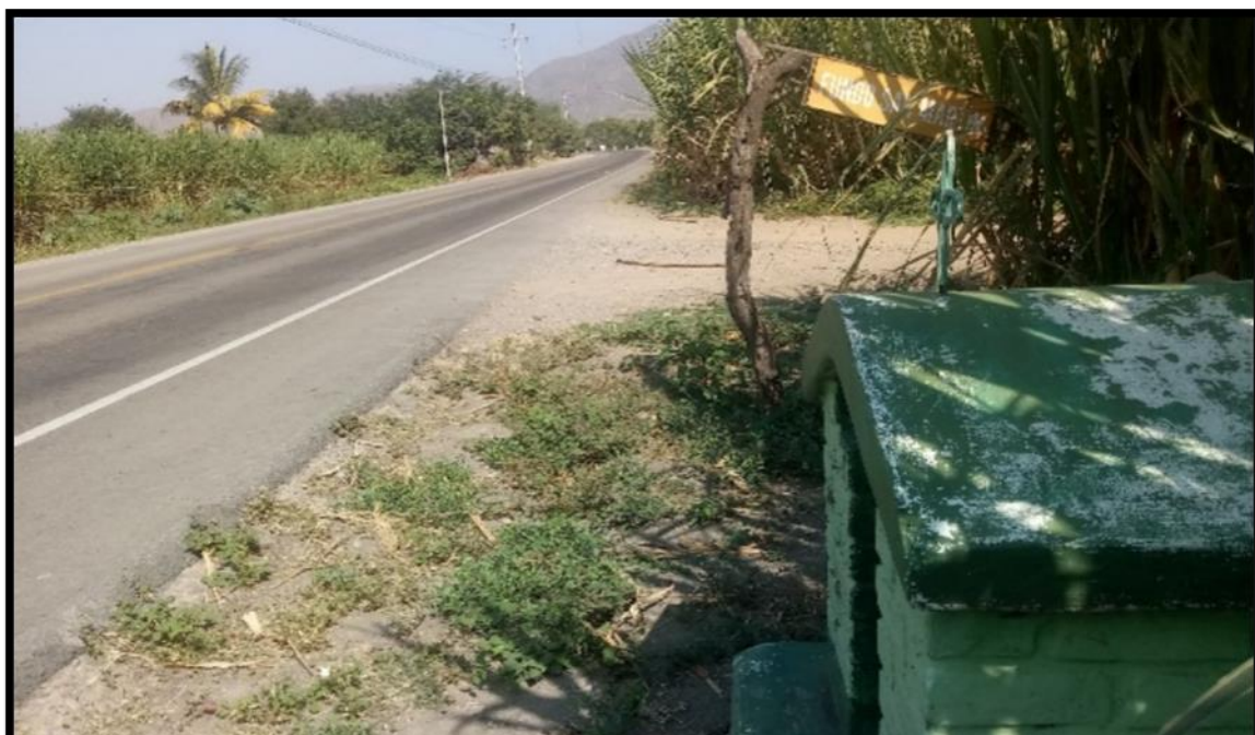
Imagen 15: Referencia a accidente de tránsito ubicado al costado de la carretera (Entre Km 48+000 y Km 49+000)
