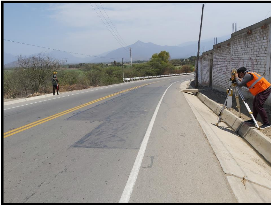
Imagen 51: Levantamiento topográfico de sectores críticos (Estación 1-Sector VI)
