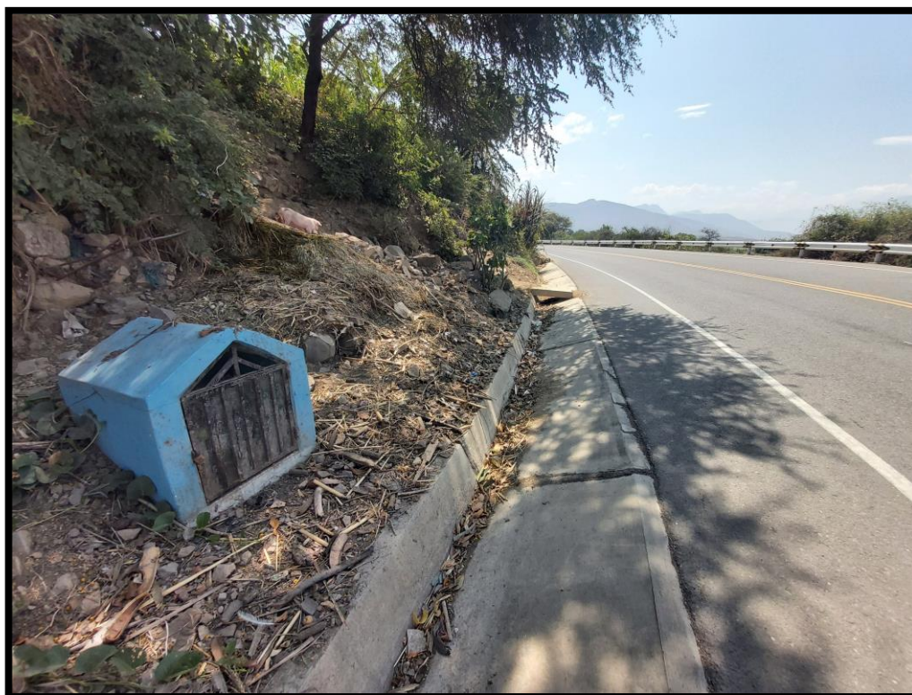
Imagen 30: Referencia a accidente de tránsito ubicado al costado de la carretera (Entre Km 66+000 y Km 67+000)
