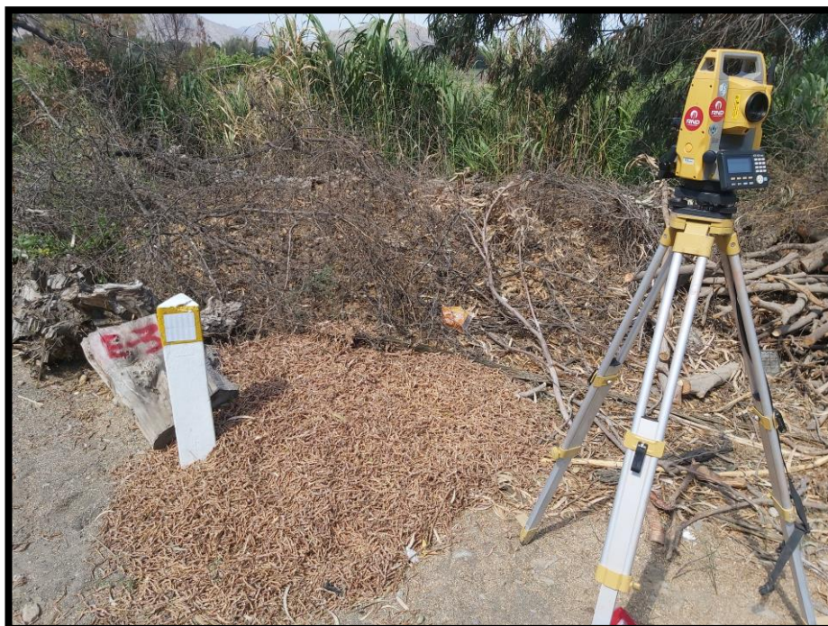
Imagen 39: Levantamiento topográfico de sectores críticos (Estación 3 – Sector III)
