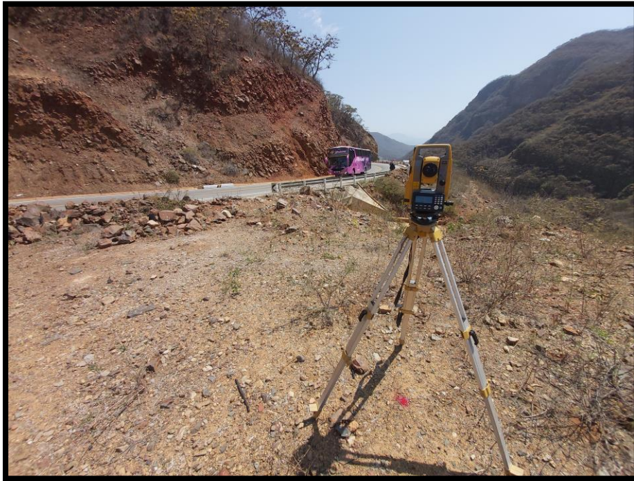
Imagen 47: Levantamiento topográfico de sectores críticos (Estación 1 – Sector VII)
