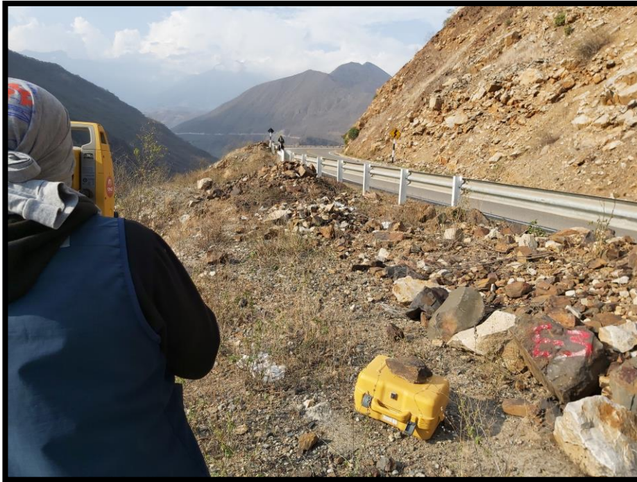
Imagen 49: Levantamiento topográfico de sectores críticos (Estación 3-Sector VII)
