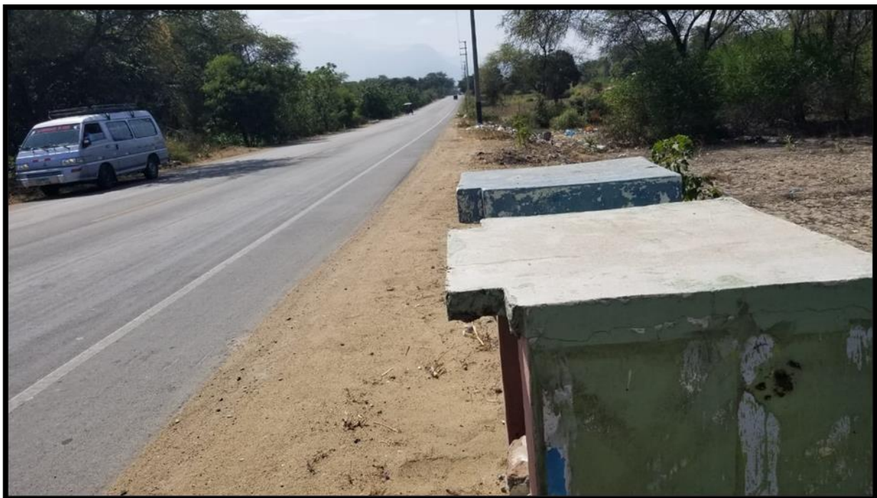
Imagen 24: Referencia a accidente de tránsito ubicado al costado de la carretera (Entre Km 32+000 y Km 33+000)
