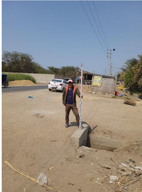
Fig. 32. Toma de BM para el tramo km 5+600 y 5+920.
