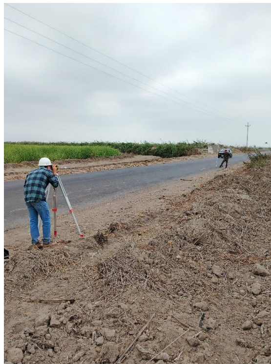
Fig. 33. Toma de datos con el nivel topográfico y mira
