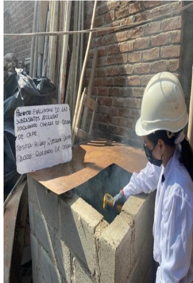
Imagen 37. Control de quemado de cáscara de Café
