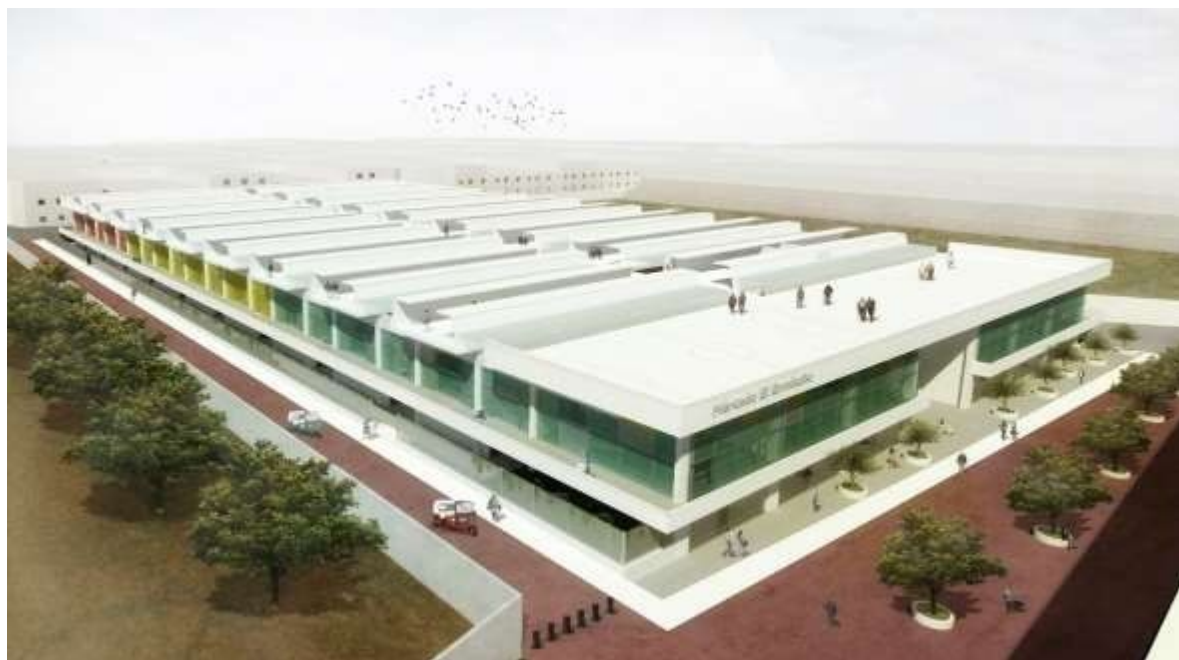
Figura 10: Vista del mercado por fuera
