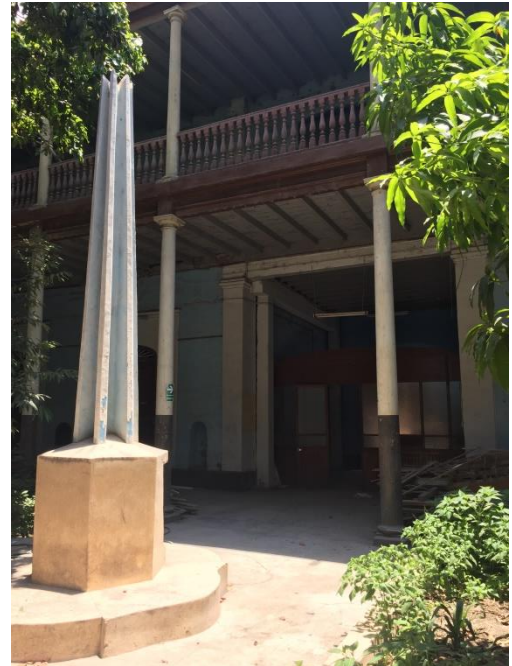
Imagen 27: Vista desde el patio central con dirección al zaguán
