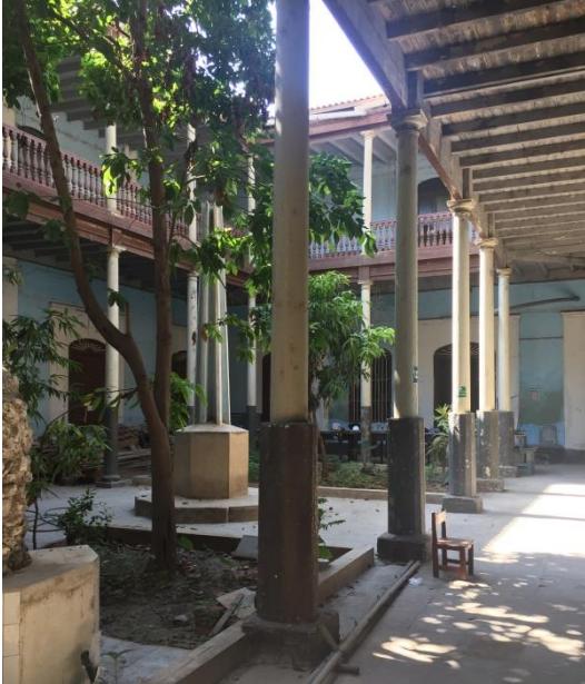
Imagen 28: Vista de Galería del Politécnico
