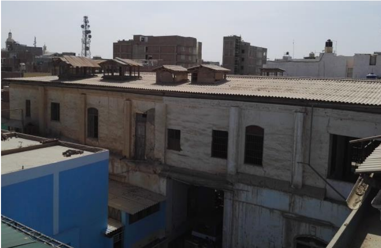
Imagen 22: Foto exterior con vista al techo
