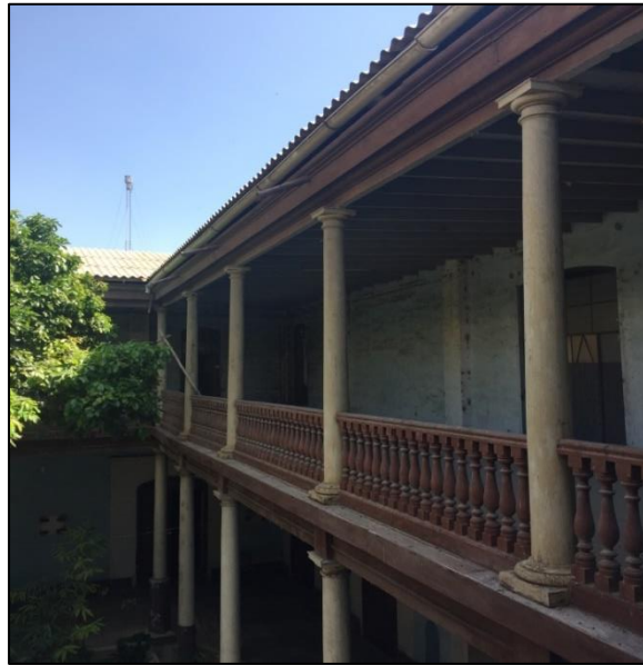
Imagen 08: Segundo nivel de Galería del Politécnico Pedro A. Labarthe
