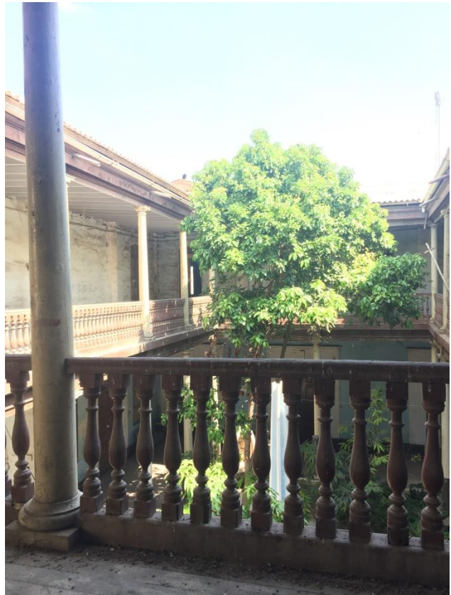
Imagen 37: Barandas con vista al patio central compuestas por balaustres
