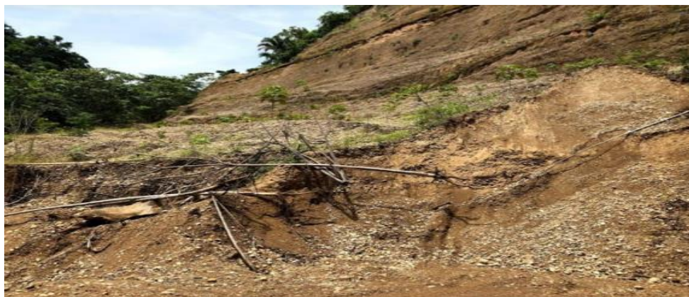
Figura 61 Vista de cantera de relleno compactado.
