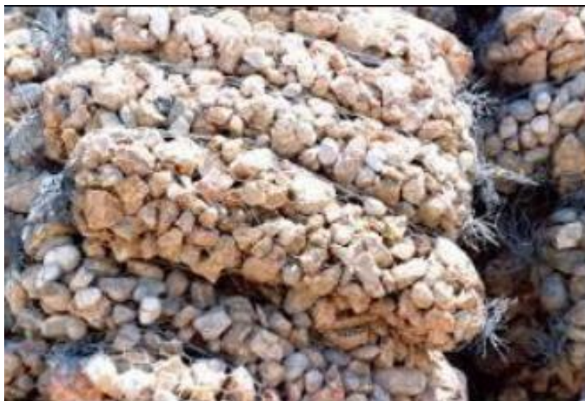
Figura 15 Cestas de mimbre rellenas de piedras Fuente: Sistema de protección y contención de taludes
