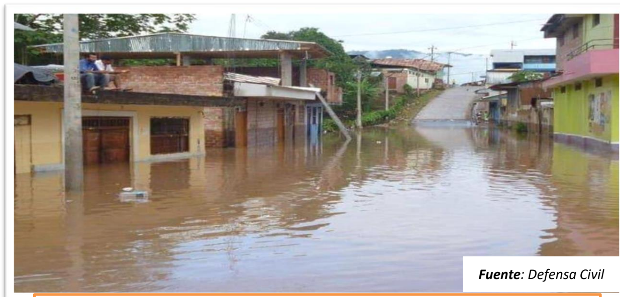
Figura 12: Viviendas afectadas en el año 2017 – Saposoa En la figura 12 se observa las viviendas que se ven afectadas por el desborde del Río Serrano margen izquierda en el Distrito de Saposoa, en el año 2017.
