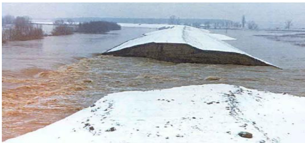
Figura 13 Falla de un dique
