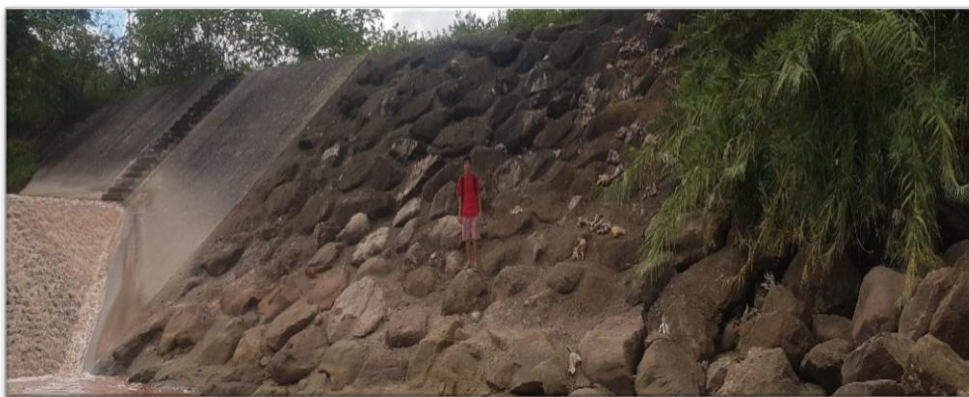
Figura 1 Defensa Ribereña en el Río Saposoa - bocatoma, 2017
