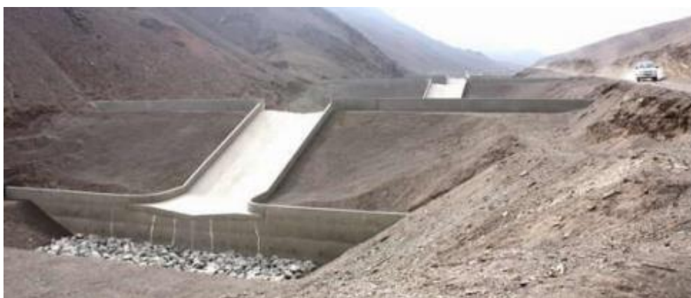
Figura 5 Piscinas decantadoras construidas en la quebrada La Cadena en la ciudad de Antofagasta
