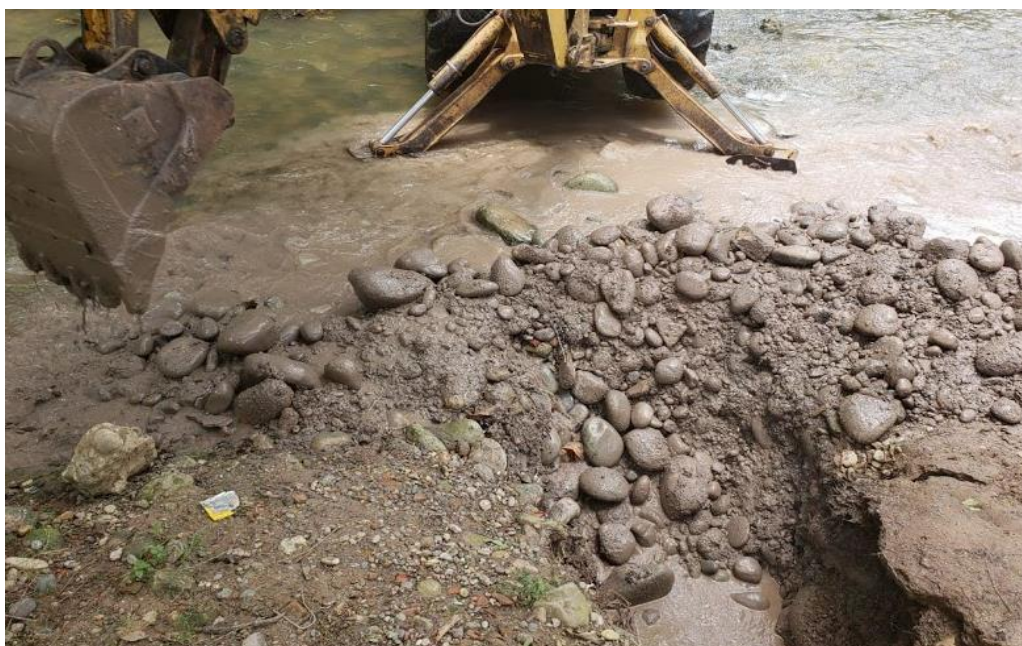
Figura 38 Vista de calicata C-01, predomina material granular gravosos y arenoso.
