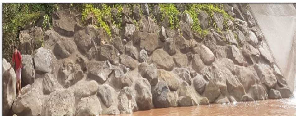
Figura 2 Defensa Ribereña en el Río Saposoa tipo Enrocado – 2017
