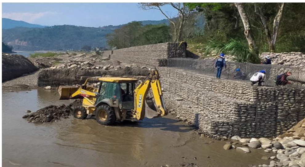
Figura 4 Construcción de defensa ribereña del Río Apurímac, en las localidades de San Martín y San Antonio del Distrito de Anco – La Mar
