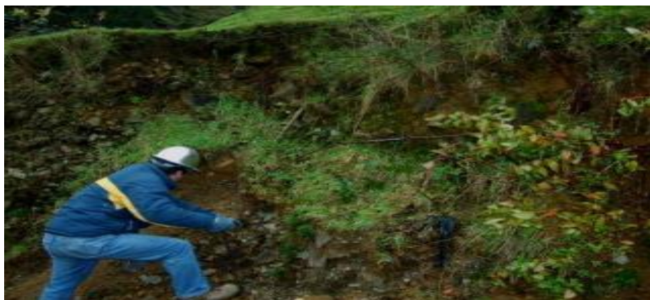
Figura 6 Talud de la zona del proyecto
