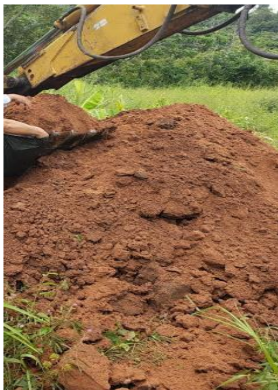
Figura 41 Vista de calicata C-02, predomina material fino arcilloso y granular areno limoso.
