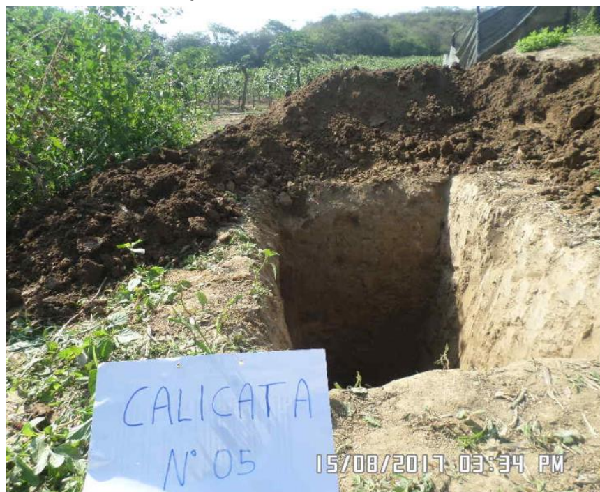
Fotografía N° 2.5: calicata canal N°05
