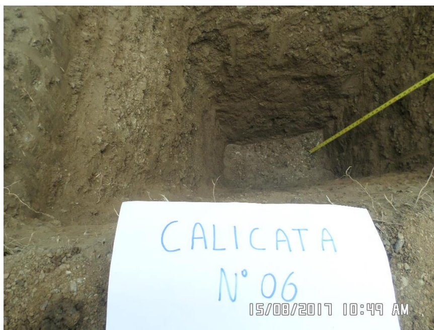
Fotografía N° 2.6: calicata canal N°06
