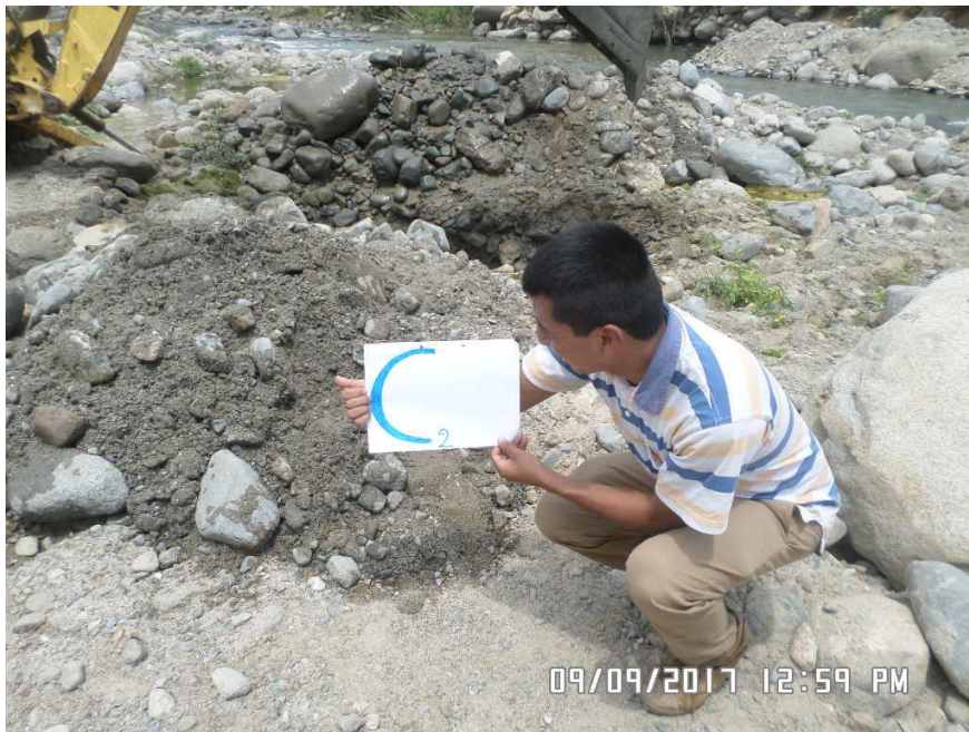
Fotografía N° 2.8: calicata río N°02
