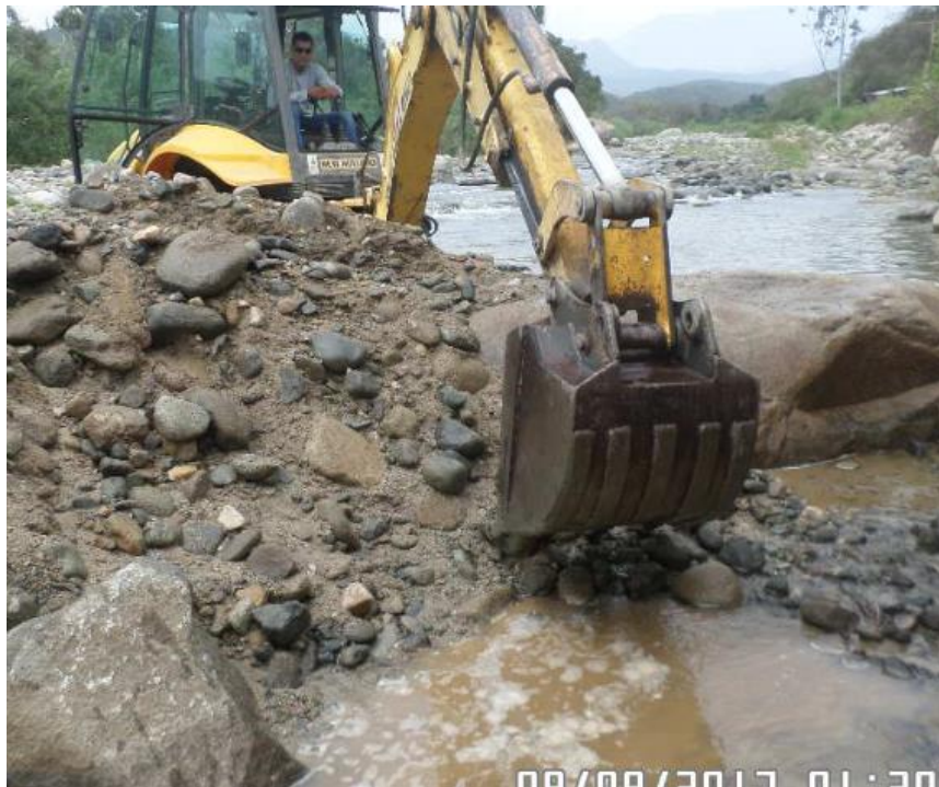
Fotografía N° 2.9: calicata río N°03
