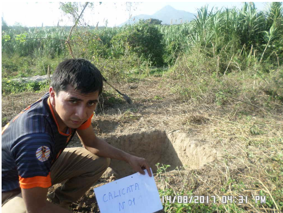
Fotografía N° 2.1: calicata canal N°01
