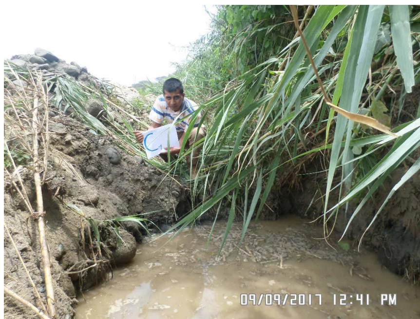
Fotografía N° 2.7: calicata río N°01
