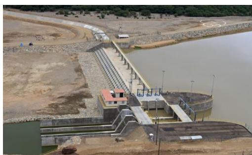
Figura N° 1: Bocatoma Miraflores - Olmos
