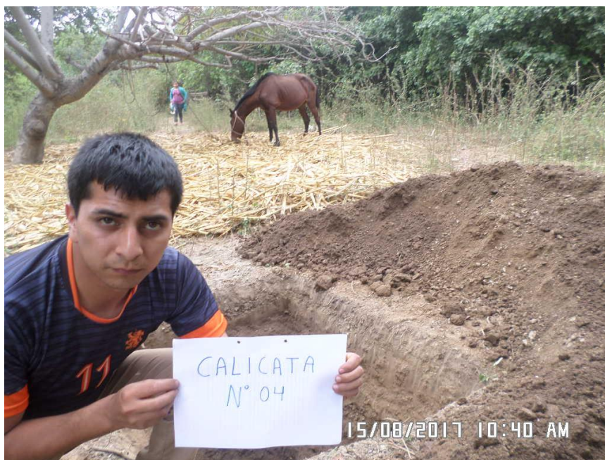
Fotografía N° 2.4: Calicata canal N° 04
