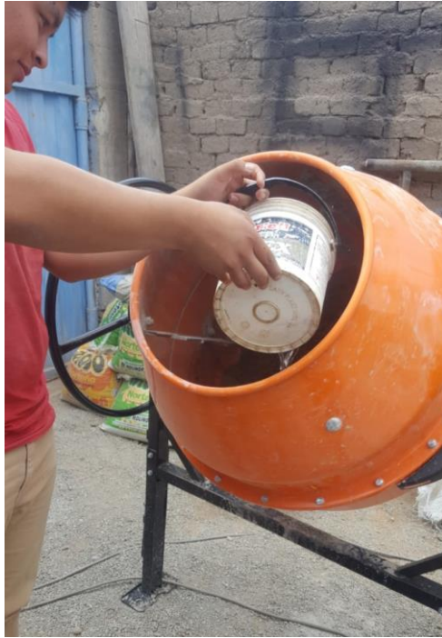
FIGURA N°34: Mezcla de los agregados
