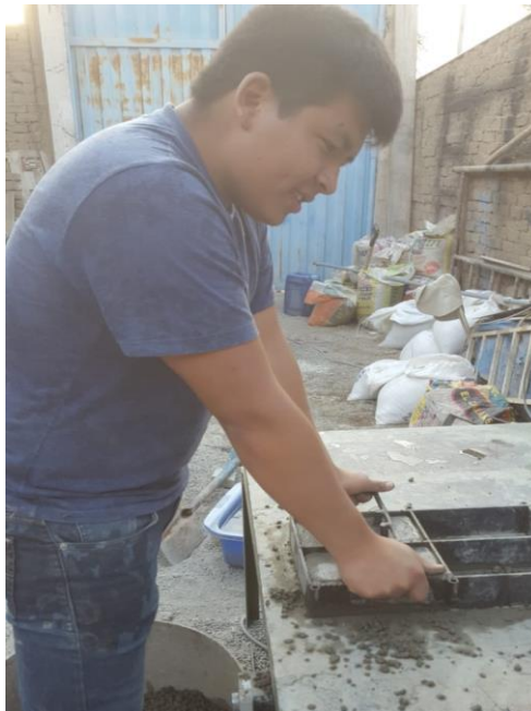
FIGURA N°35: Moldeado de los adoquines de concreto
