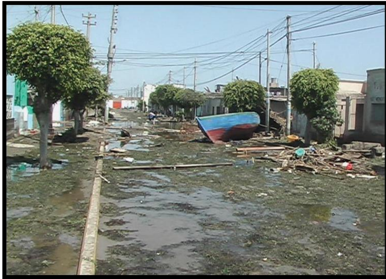
Imagen N° 78 Arrastre de embarcaciones y escombros causados por el tsunami en Pisco el 2007.
