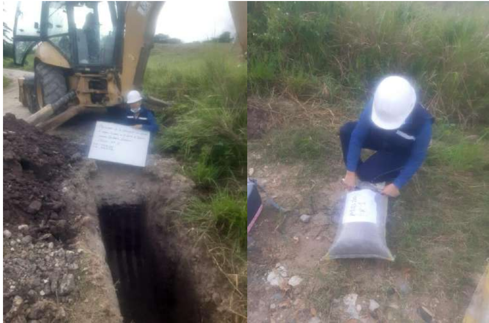
Figura 1 Excavación de la calicata 1
