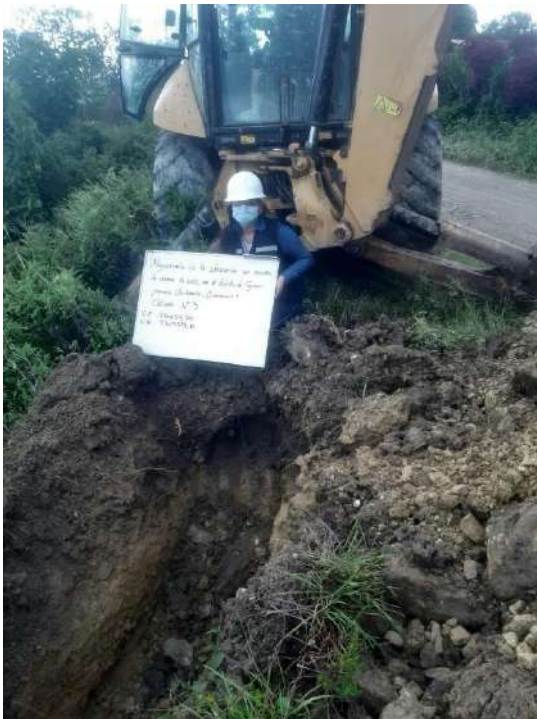
Figura 19 Excavación de la calicata 9
