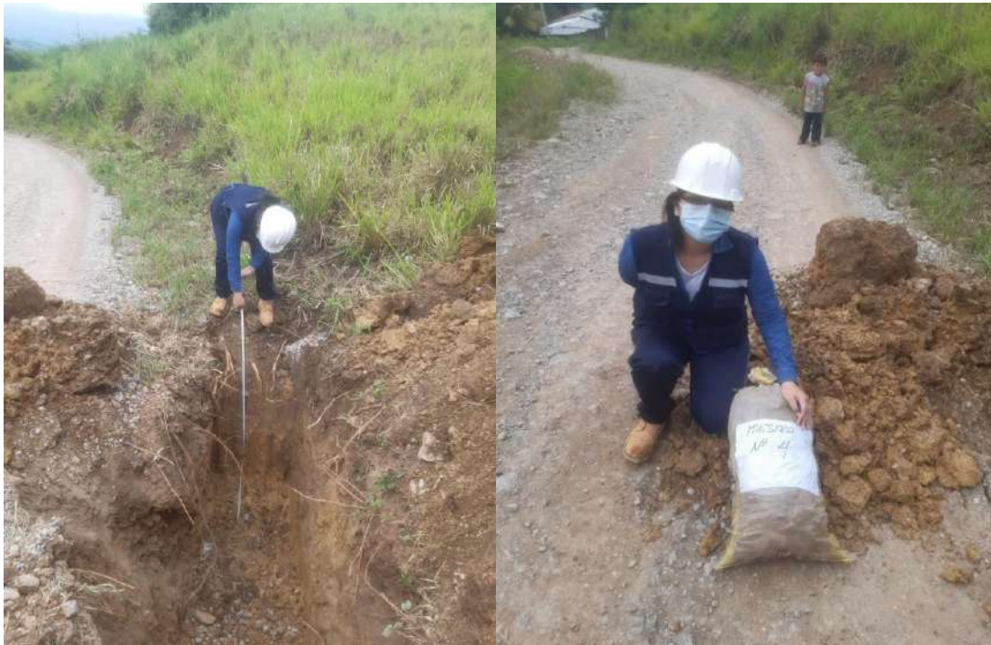
Figura 4 Excavación de la calicata 4
