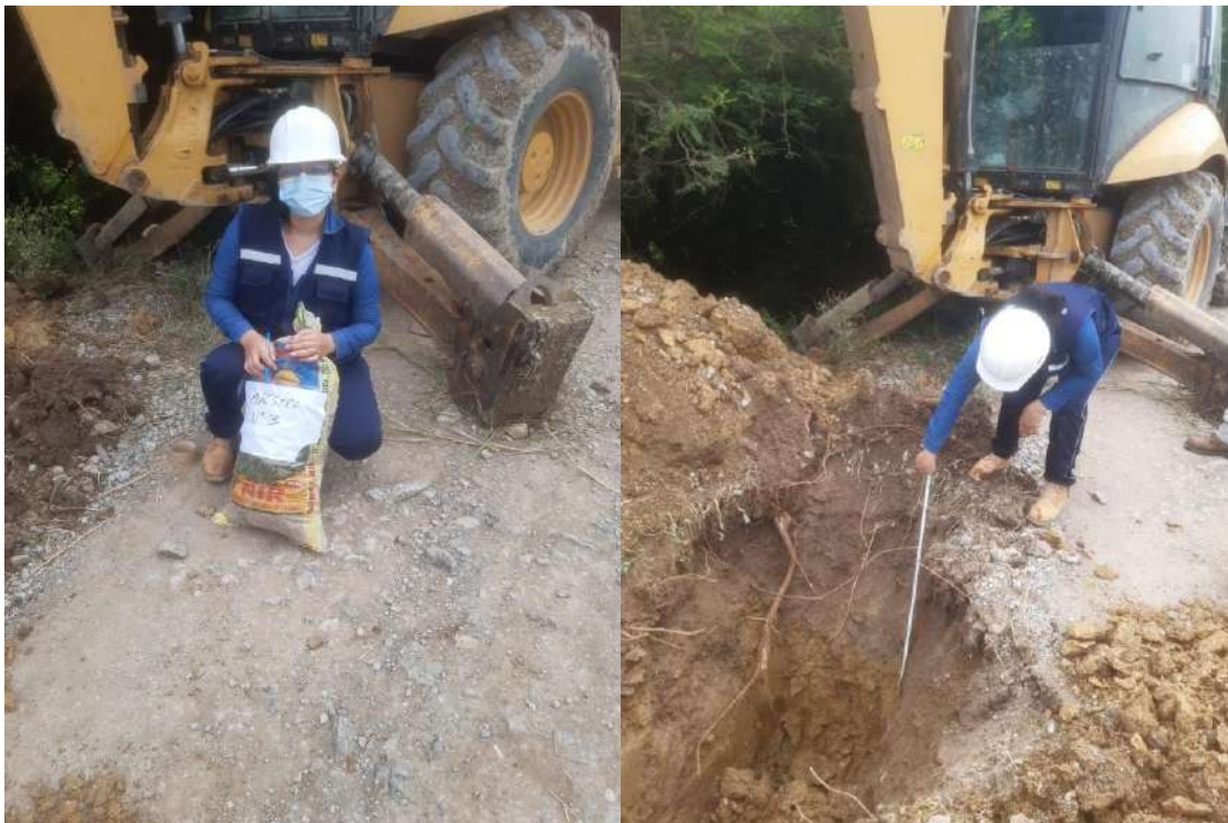
Figura 13 Excavación de la calicata3
