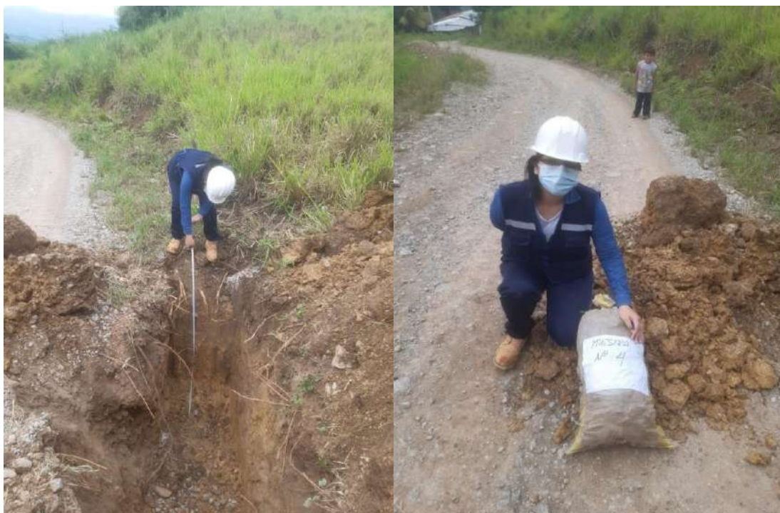
Figura 14 Excavación de la calicata4
