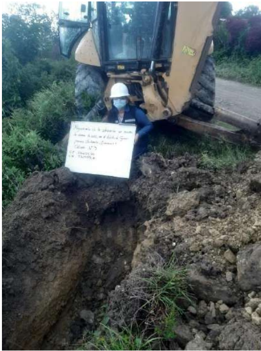
Figura 9 Excavación de la calicata 9
