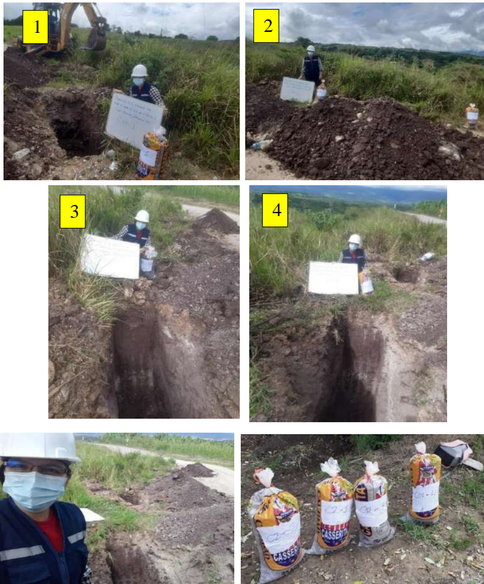
Figura 11 Excavación de las 4 calicatas (C-2)
