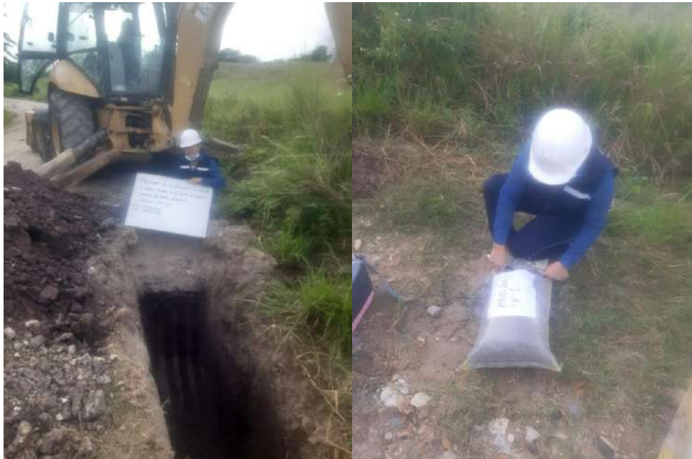
Figura 11 Excavación de la calicata1
