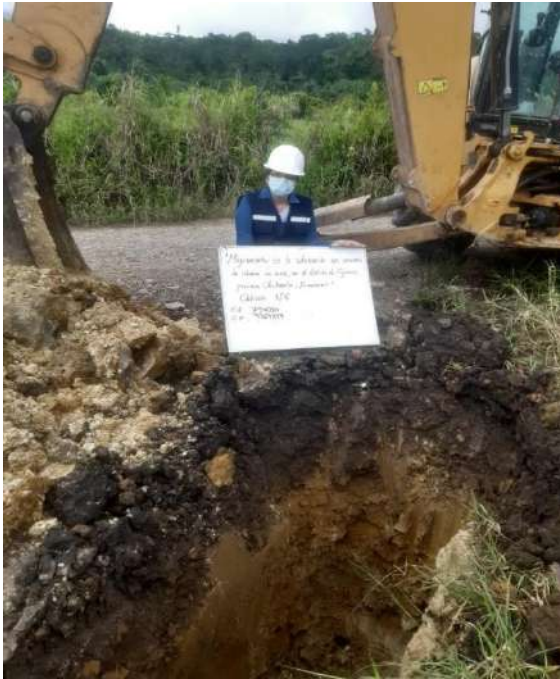
Figura 6 Excavación de la calicata 6
