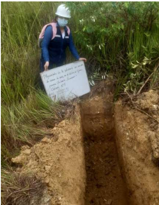
Figura 18 Excavación de la calicata 8
