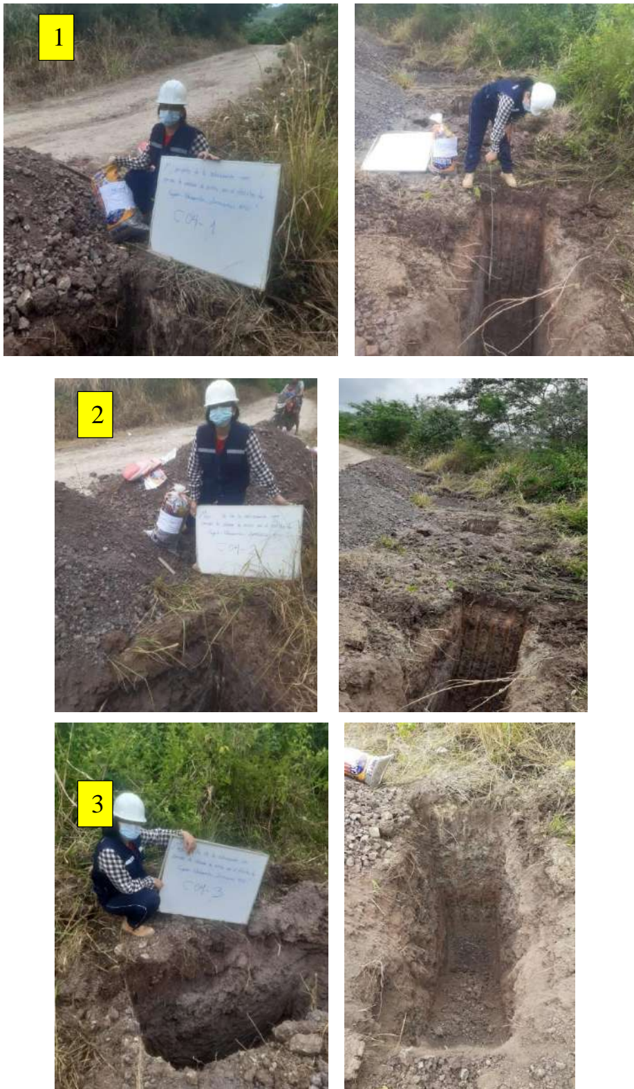
Figura 30 Excavación de las 4 calicatas (C-4)
