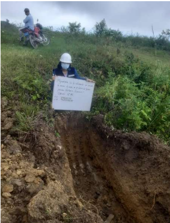
Figura 10 Excavación de la calicata 10
