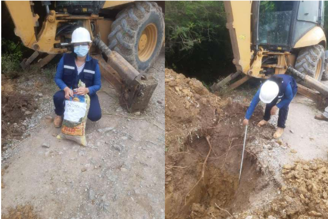
Figura 3 Excavación de la calicata 3
