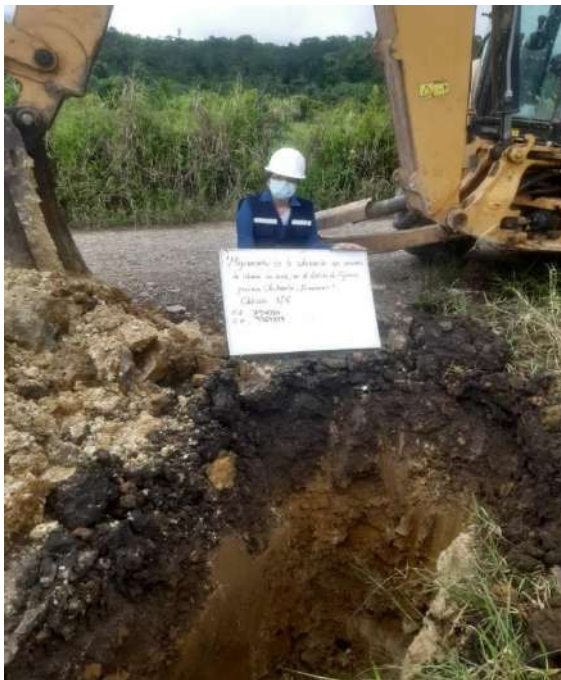
Figura 16 Excavación de la calicata 6
