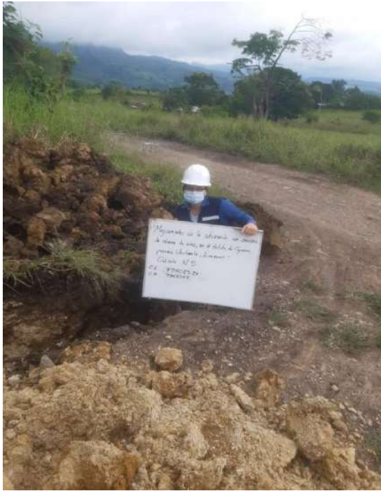
Figura 5 Excavación de la calicata 5
