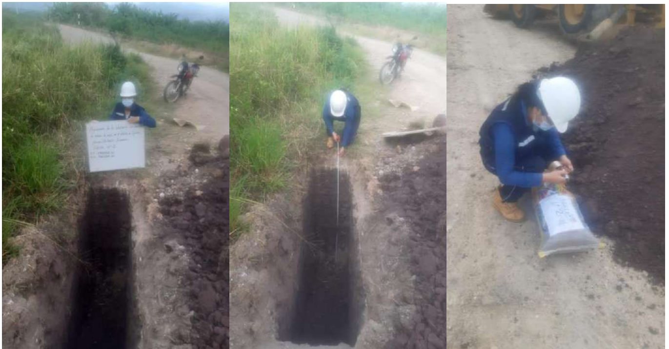
Figura 2 Excavación de la calicata 2
