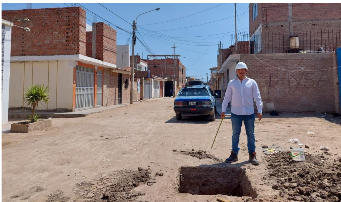
Figura 6. Calicata N° 02 en Calle El Vaticano S/N Mz “E” – Sector Las Brisas
