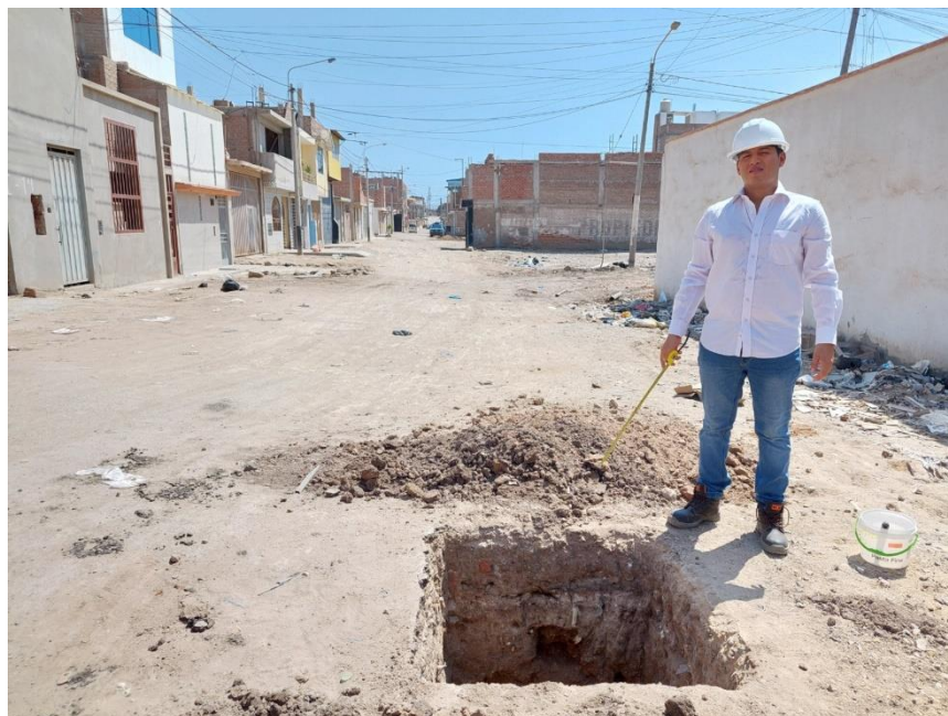
Figura 7. Calicata N° 03 en Calle El Vaticano S/N Mz “E” – Sector Las Brisas
