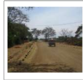
Foto 1. Caminos Fuente Elaboración Propia
