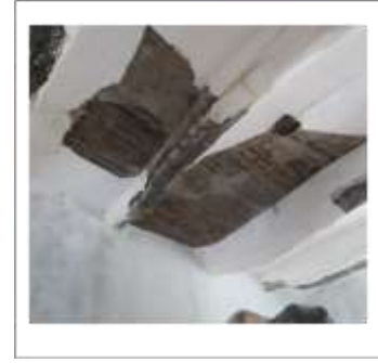
Foto 4. Vista interior de la cocina. Fuente: Elaboración Propia
